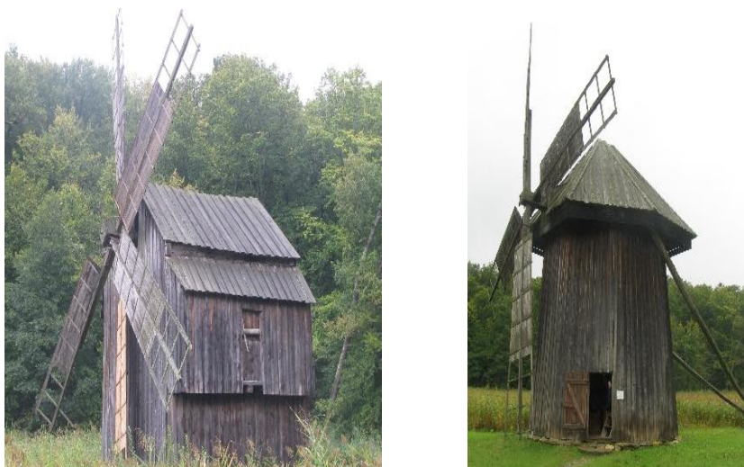
Figura 2-10 – Moară de vânt cu etaj (Frecăței) și Moară de vânt căciulată (Beștepe)
