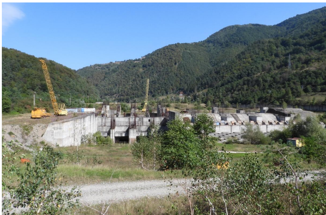
Figura 10. Centrala CHE Căineni, zona prizei și camera spirală – vedere din aval
