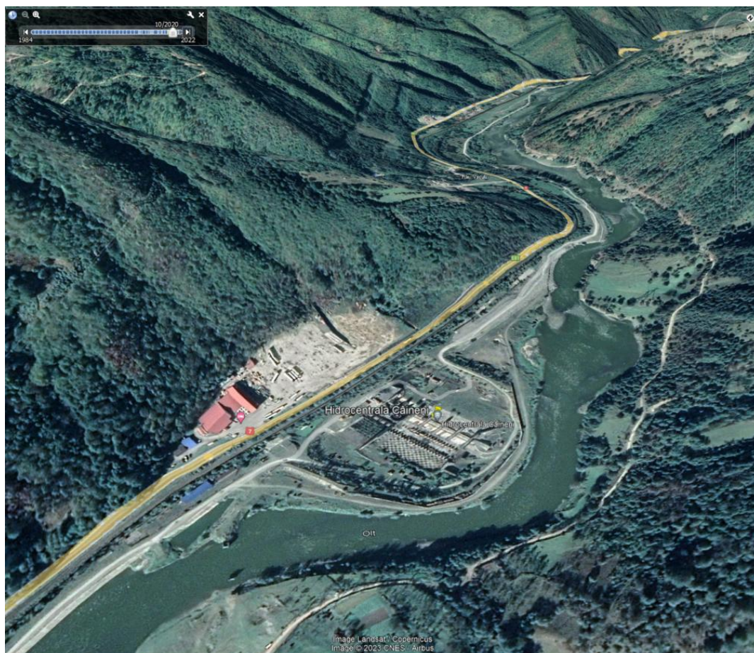
Figura 8. CHE Căineni – vedere de ansamblu; Sursă Google Earth
