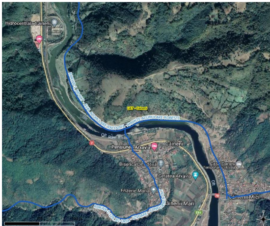
Figura 9. CHE Căineni – vedere de sus; Sursă Google Maps
