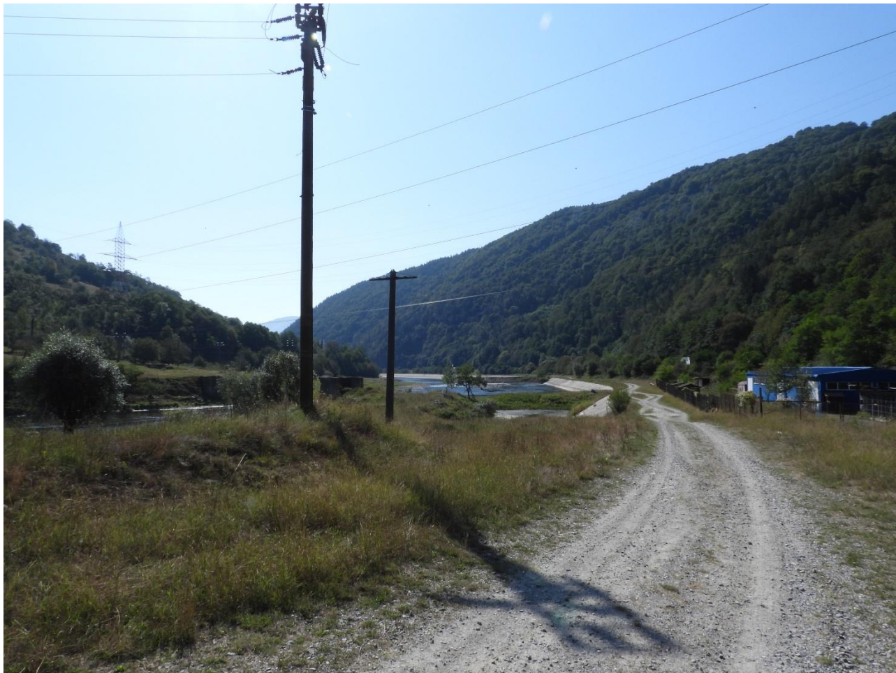
Figura 7. Vedere aval CHE, Căineni
