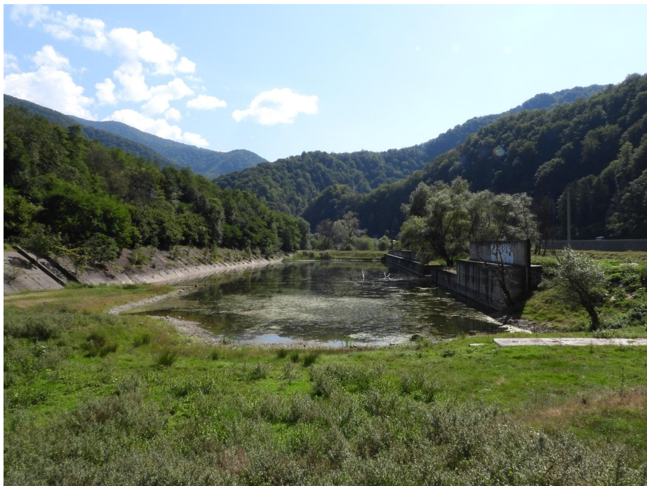
Figura 13. Centrala CHE Lotrioara
