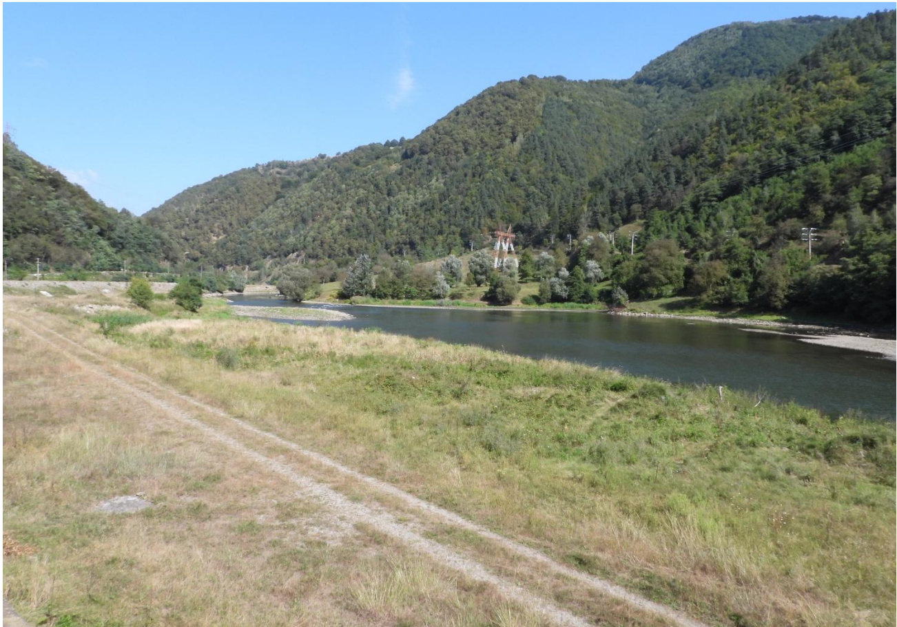
Figura 11. Vedere amonte - zona Lacului de acumulare Căineni
