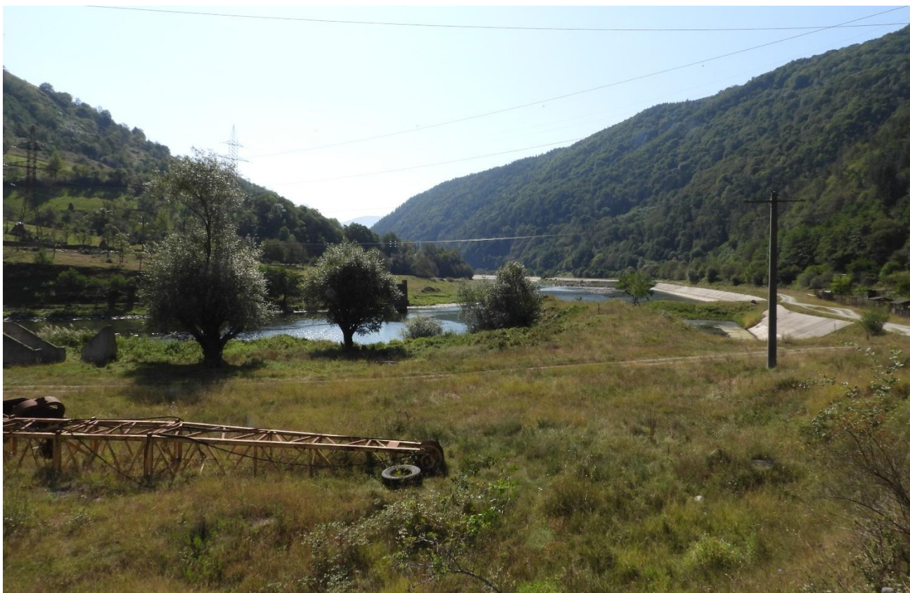
Figura 12. Vedere aval - zona Canal de Fugă CHE Căineni
