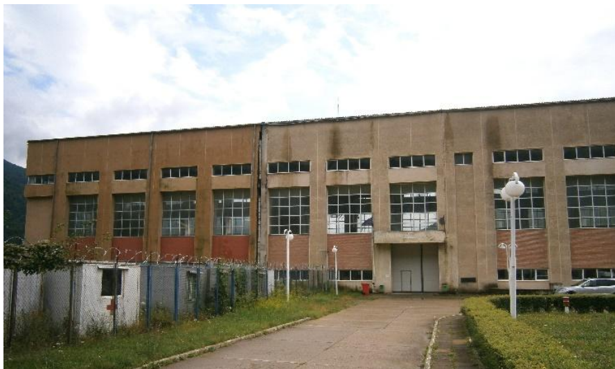
Foto nr. 8 – Clădire CHE Nehoiașu
