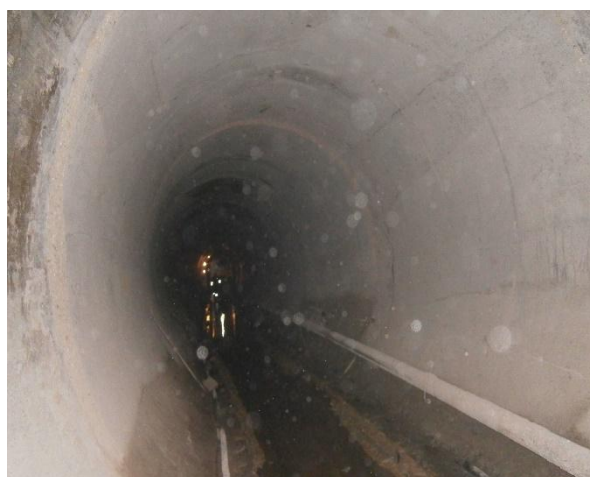
Foto nr. 5 – Galeria de aducțiune – interior
