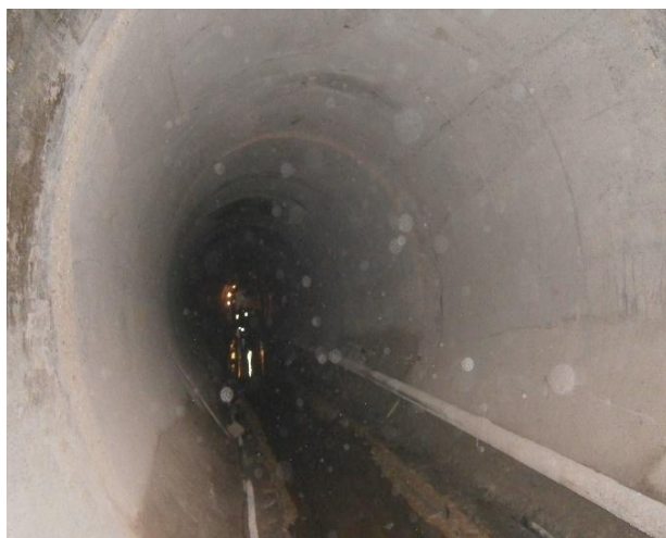
Foto nr. 5 – Galeria de aducțiune – interior
