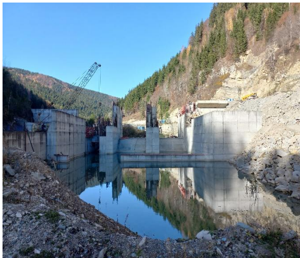
Foto nr. 1 – Vedere din aval
