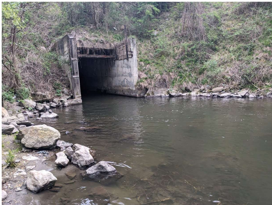
Figura nr. 156 Evacuarea apei râului Belareca aval baraj Cornereva
