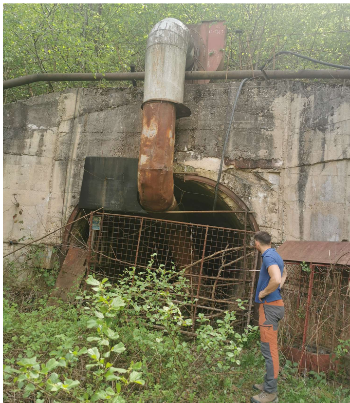
Figura nr. 34 – Intrarea în galeria de aducțiune din arealul barajului Cornereva (diam. 4,6 m). Vegetația ruderală (habitat din sistemul românesc de clasificare) adiacentă este înlocuită progresiv de păduri ripariene (habitatul 92A0)
