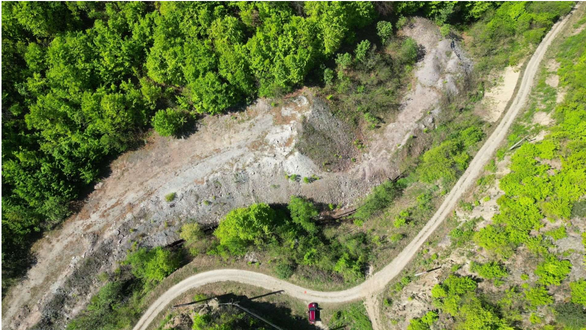
Figura nr. 58 – Fotografie aeriană asupra capătului aval al perimetrului șantierului ferestrei de atac Bolvașnița 2
