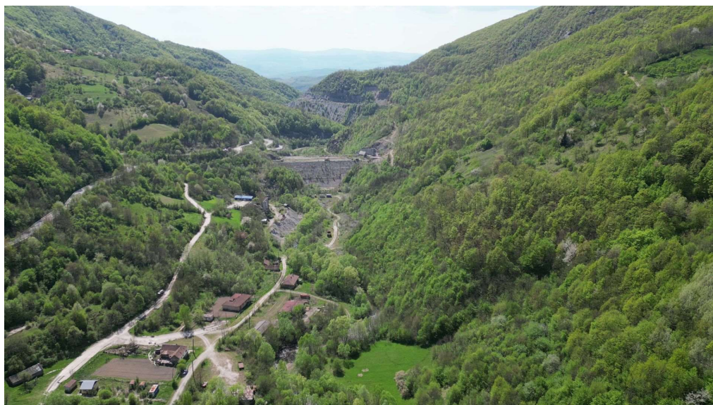
Figura nr. 31 – Imagine aeriană a părții aval a cuvetei lacului de acumulare Cornereva. Se poate observa arealul rezidențial încă folosit și fragmentele de pajiști mezofile (habitatul N2000 6510) de la baza versantului drept
