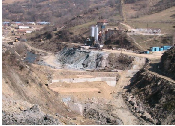
Figura 6 - Batardou amonte. Vedere din timpul execuției – martie 2007
