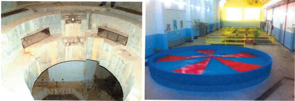
Figura 10 - CHE Herculane. Locul de montaj al HA3
