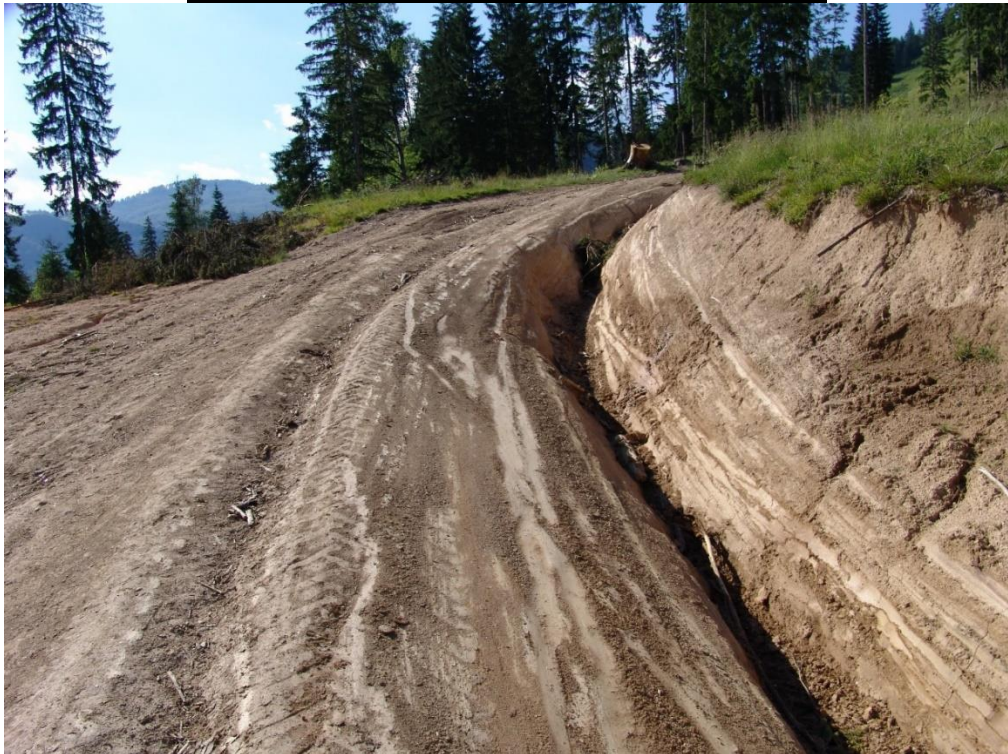
Figura 80. Ilustrarea impactului asociat unui drum forestier de exploatare; se observă ogașele profunde cauzate de fenomenele erozive, tasările generate de târârea arborilor și zonele extinse de afectare ca urmare a insuficientei pregătire a zonelor de schimbare a direcției
