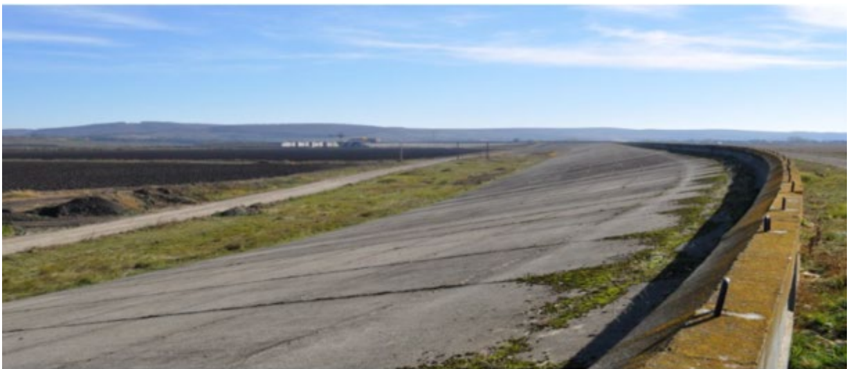
Figura 4. Dig mal drept, lucrări finalizate
