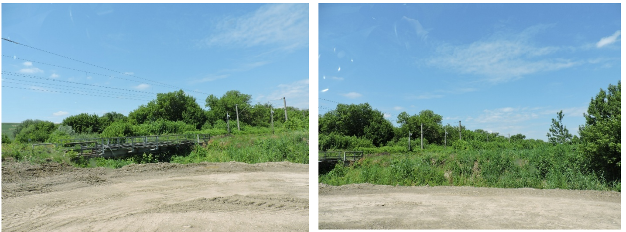
Figura 29. Linia de cale ferată existentă în vecinătatea AHE Pașcani
