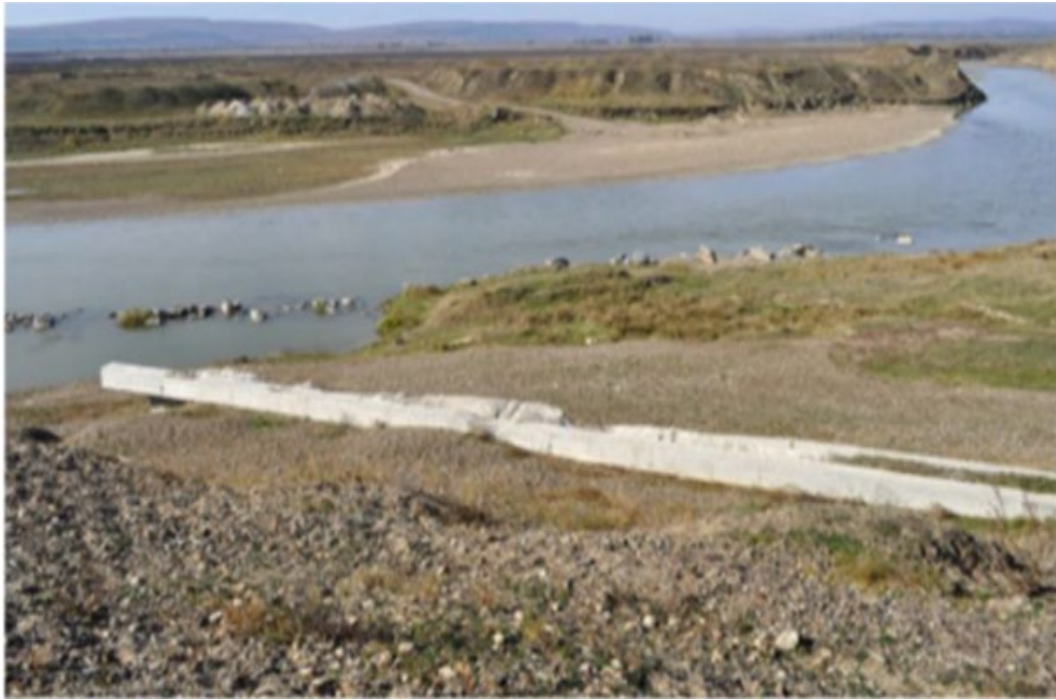
Figura 3. Dig mal stâng, lucrări finalizate
