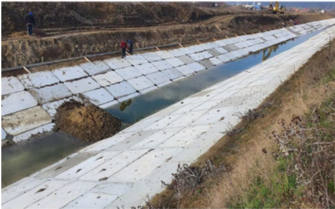
Figura 5. Canal colector dig mal drept, lucrări finalizate
