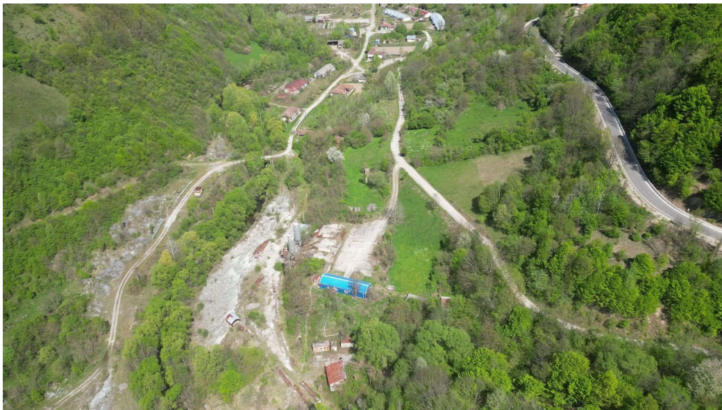
Figura nr. 75 – Imagine aeriană cu arealele puternic disturbate de lucrările de șantier din arealul aval al viitorului lac de acumulare Cornereva, în punctul unde începe galeria de aducțiune spre Cerna
