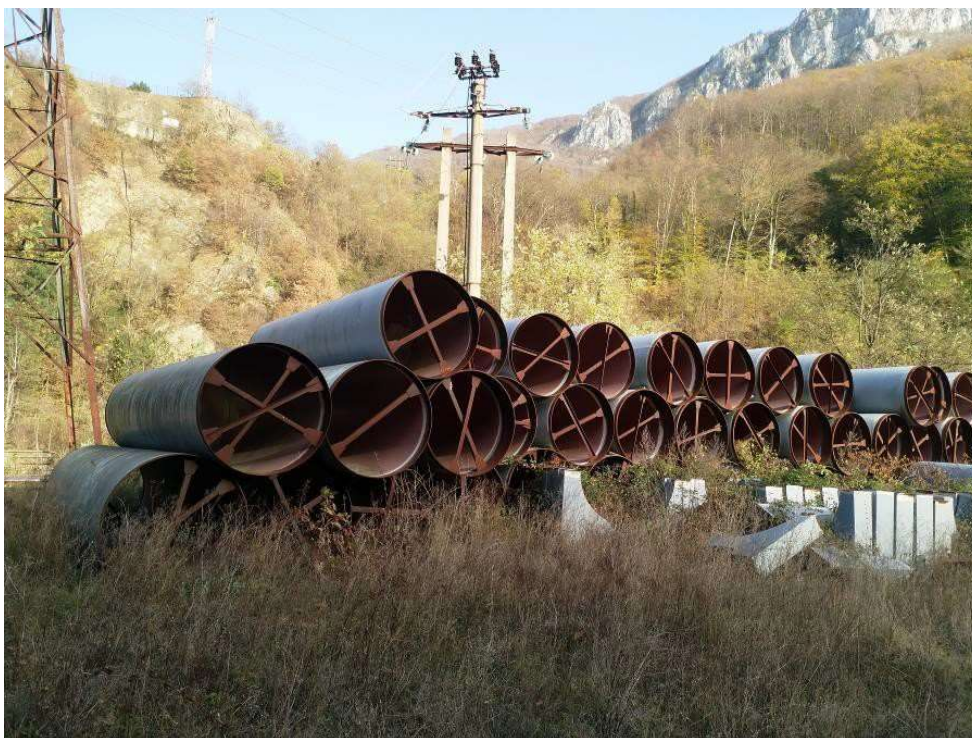
Figura nr. 51 Conducta forțată aflată în custodia Energomontaj
