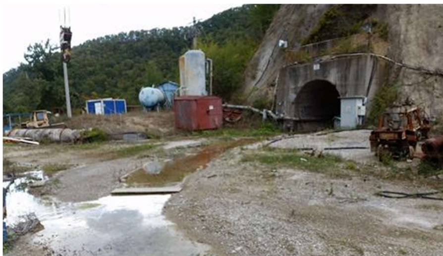
Figura nr. 47 Portalul galeriei de aducțiune de la front castel
