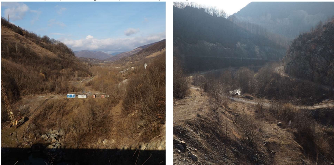
Figura nr. 55 - Corpul de apă Bela Reca - izvor - confluență Mehadica + afluenți (vedere de pe baraj Cornereva spre amonte – stânga și spre aval - dreapta)
