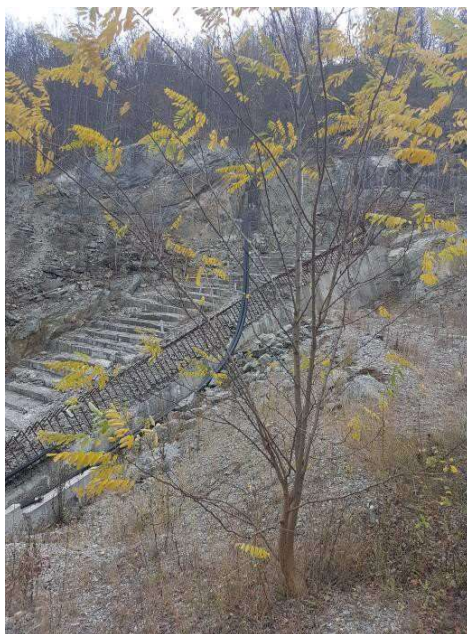
Figura nr. 24 Vatra barajului. Zona versant stâng
