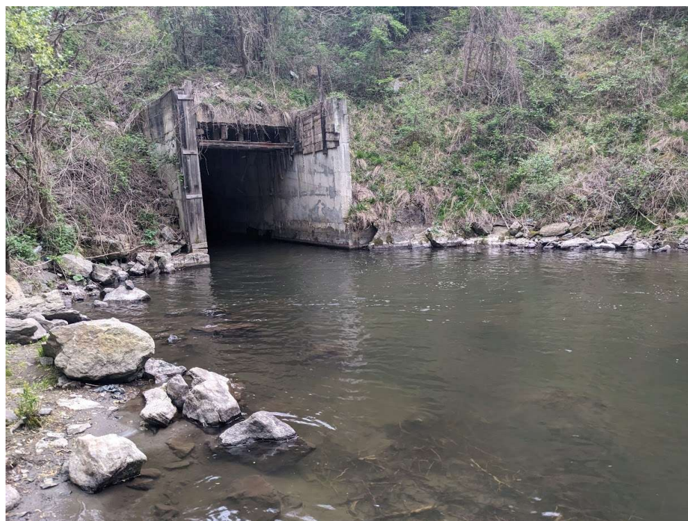
Figura nr. 204 Evacuarea apei râului Belareca aval baraj Cornereva
