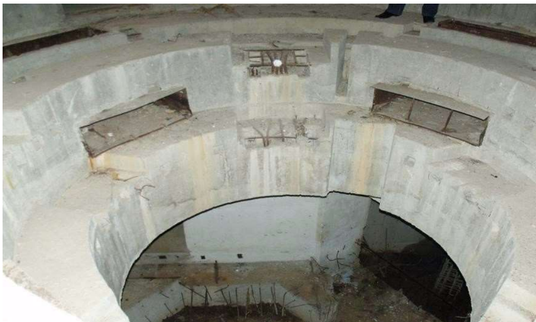
Figura nr. 52 CHE Herculane. Fundație generator HA3
