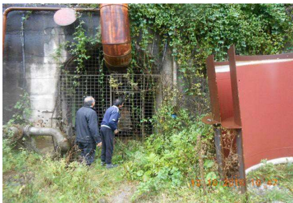
Figura nr. 45 Platforma tehnologică Bolvașnița II nemontate
