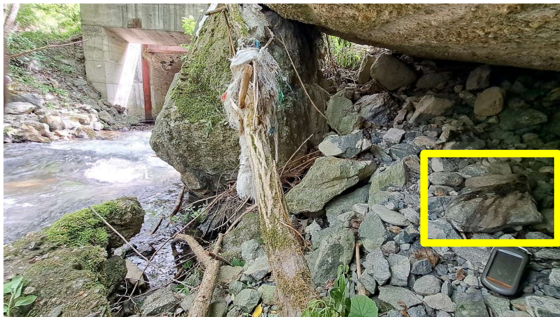
Figura nr. 159 Latrină de vidră sub o placă de beton, lângă captarea de pe râul Belareca.
