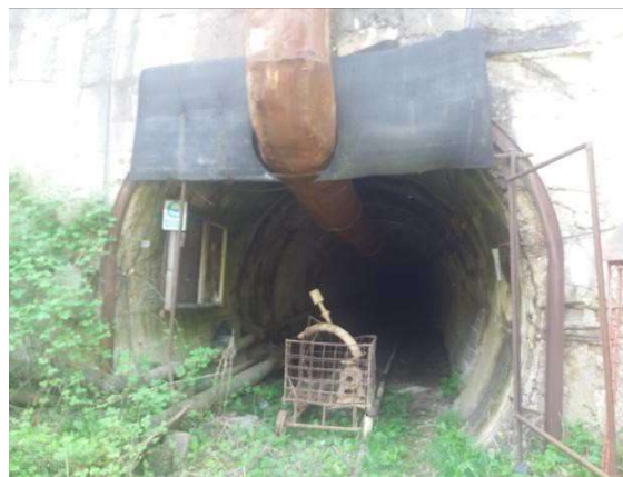
Figura nr. 43 Platforma tehnologică și portalul galeriei de aducțiune de la priza Cornereva
