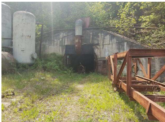
Figura nr. 43 Platforma tehnologică și portalul galeriei de aducțiune de la priza Cornereva
