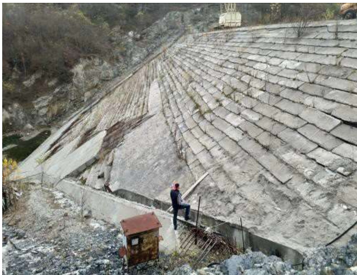
Figura nr. 23 Vatra barajului. Zona versant drept
