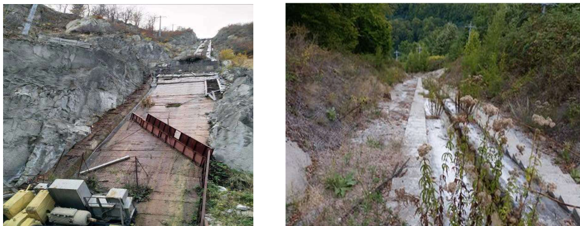
Figura nr. 49 Vegetație în tranșeea conductei forțate și pe taluz
