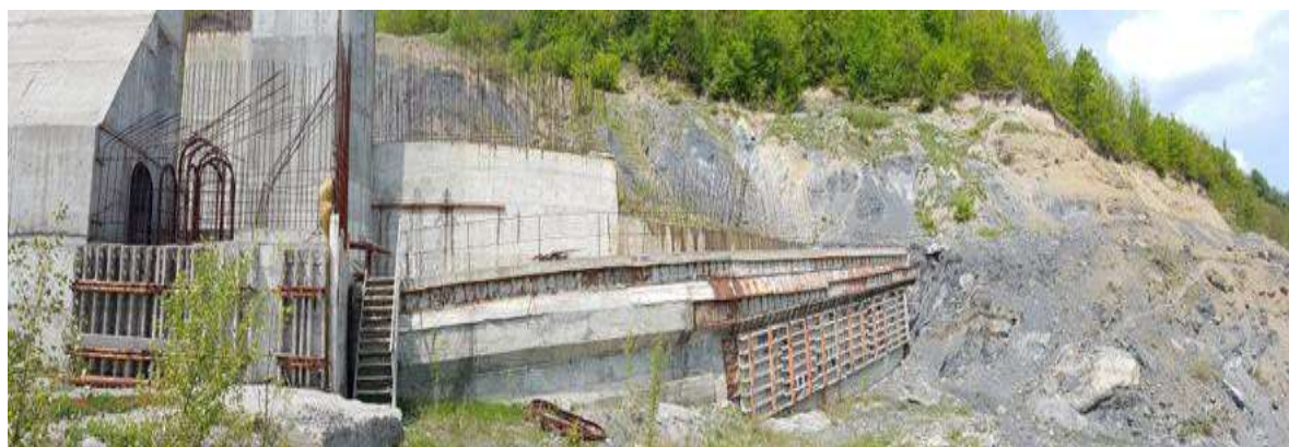
Figura nr. 35 Evacuatorul de ape mari. Vedere din aval
