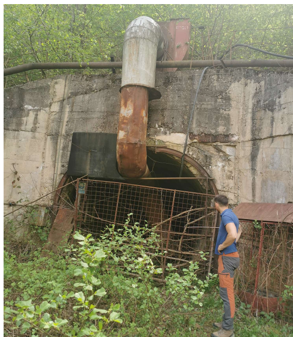
Figura nr. 82 – Intrarea în galeria de aducțiune din arealul barajului Cornereva (diam. 4,6 m). Vegetația ruderală (habitat din sistemul românesc de clasificare) adiacentă este înlocuită progresiv de păduri ripariene (habitatul 92A0)
