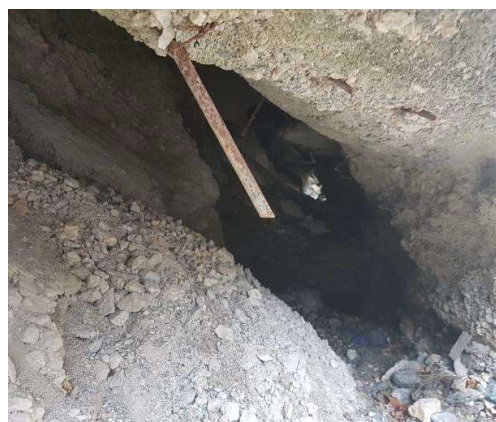
Figura nr. 32 Caverne sub prefabricatele deja montate – zonă versant drept – zona 2
