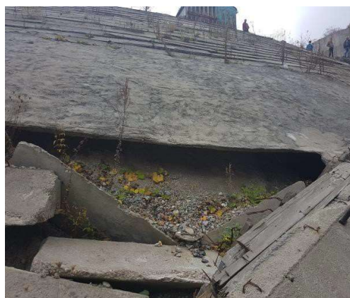
Figura nr. 32 Caverne sub prefabricatele deja montate – zonă versant drept – zona 2
