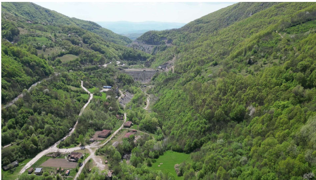
Figura nr. 79 – Imagine aeriană a părții aval a cuvetei lacului de acumulare Cornereva. Se poate observa arealul rezidențial încă folosit și fragmentele de pajiști mezofile (habitatul N2000 6510) de la baza versantului drept
