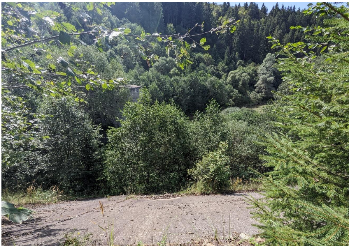
Foto nr. 28 Barajul Cireșu, localizat amonte de barajul Surduc
