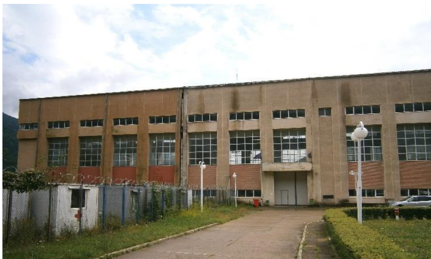
Foto nr. 8 – Clădire CHE Nehoiașu
