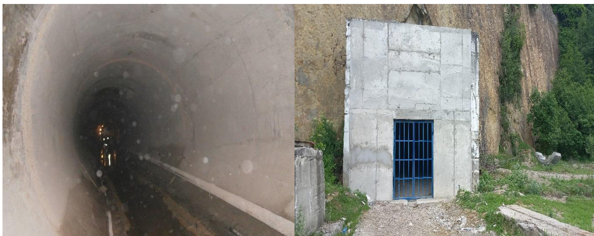
Foto nr. 5 – Galeria de aducțiune – interior
