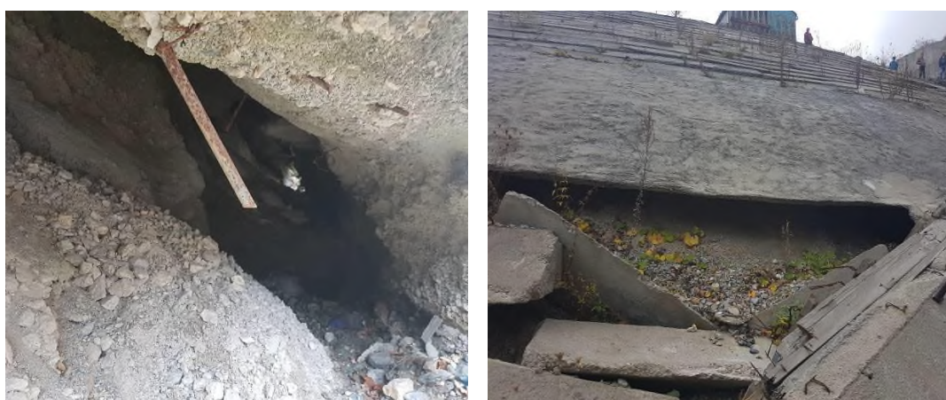
Fig. 32 Caverne sub prefabricatele deja montate – zonă versant drept – zona 2
