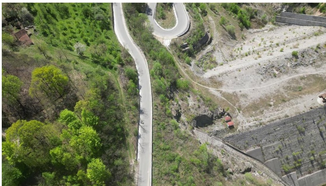
Fig. 81 – Imagine aeriană cu flancul stâng al barajului Cornereva, acolo unde este ancorat în versantul corespondent, în conglomeratele cuarțitice ale Formațiunii de Gresten. Vegetația de aici, pionieră, nu este considerată a reprezenta habitate N2000
