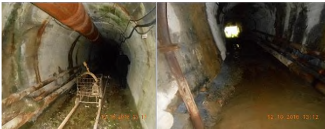
Fig. 44 Galeria de aducțiune. Front priză Cornereva
