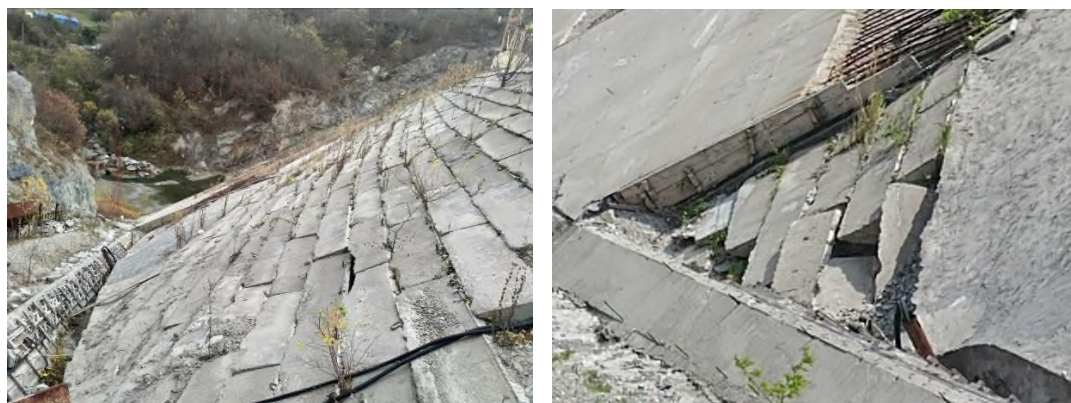
Fig. 31 Caverne sub prefabricatele deja montate – zonă versant drept – zona 1
