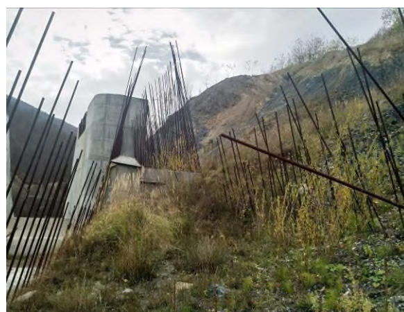
Fig. 37 Evacuatorul de ape mari - zonă alunecare
