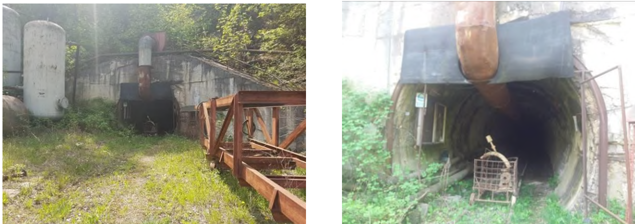
Fig. 43 Platforma tehnologică și portalul galeriei de aducțiune de la priza Cornereva
