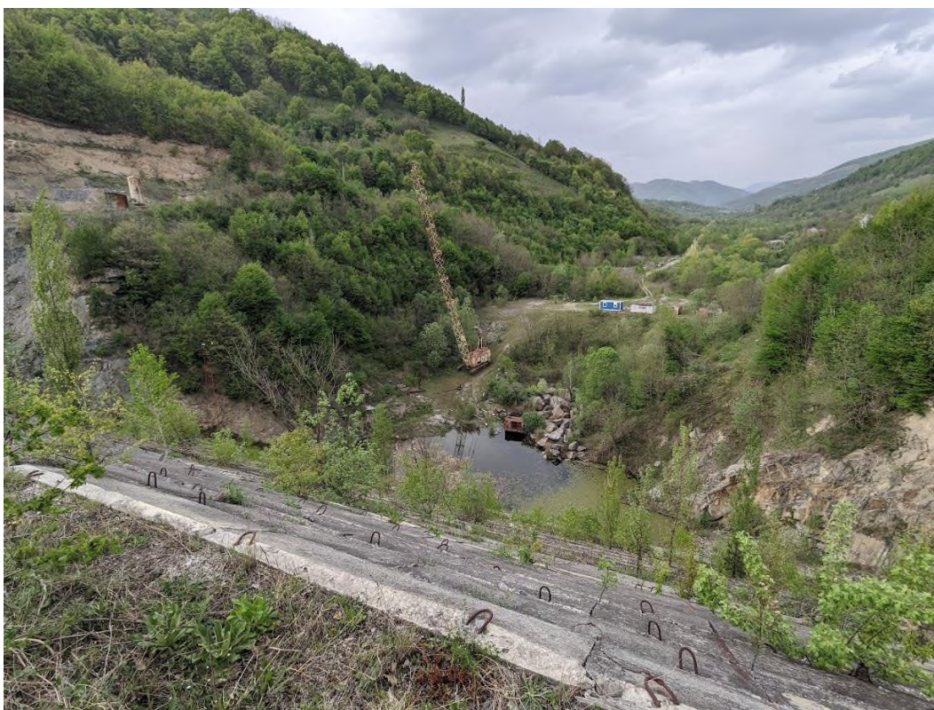
Fig. 203 Barajul Cornereva – vedere în amonte
