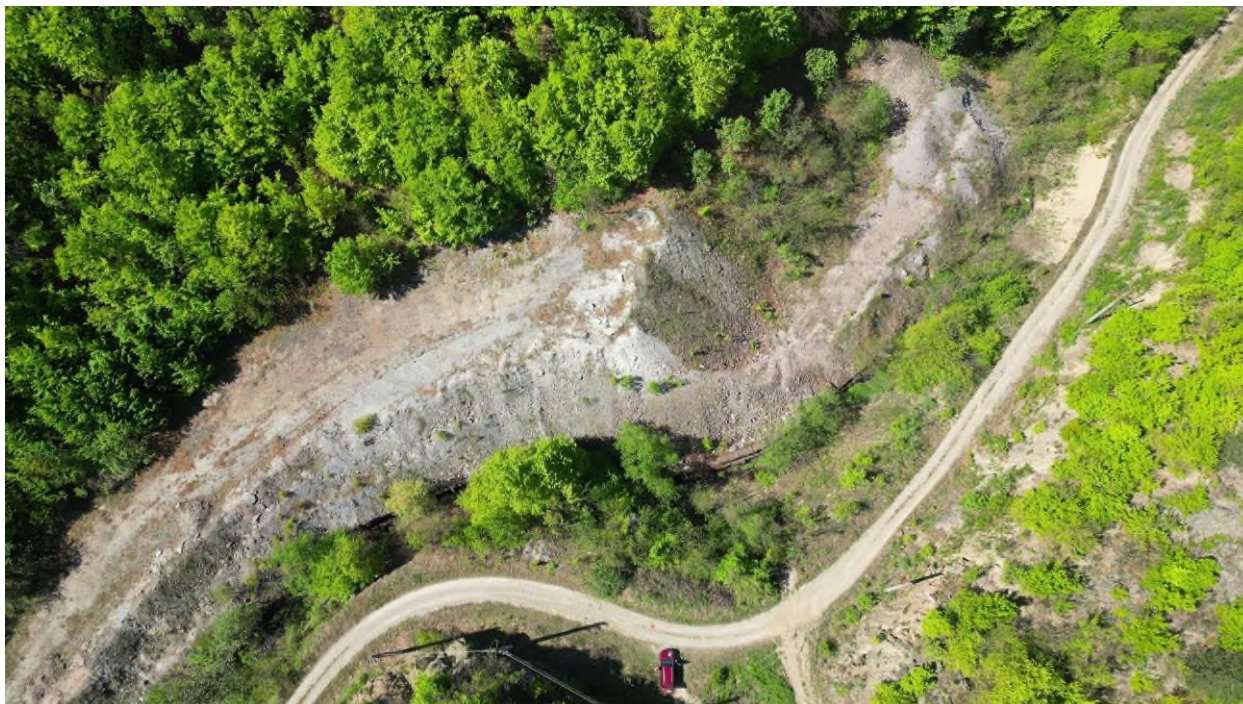
Fig. 106 – Fotografie aeriană asupra capătului aval al perimetrului șantierului ferestrei de atac Bolvașnița II
