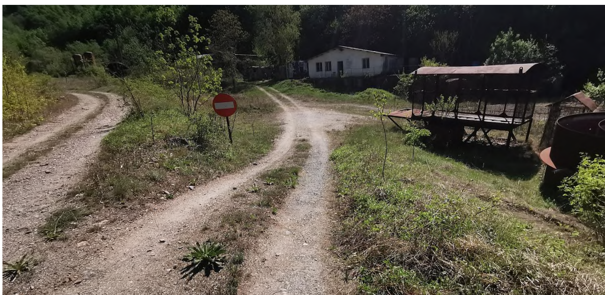
Fig. 107 – Aspect din perimetrul șantierului ferestrei de atac Bolvașnița II cu vegetație ruderală (habitat din sistemul românesc de clasificare)
