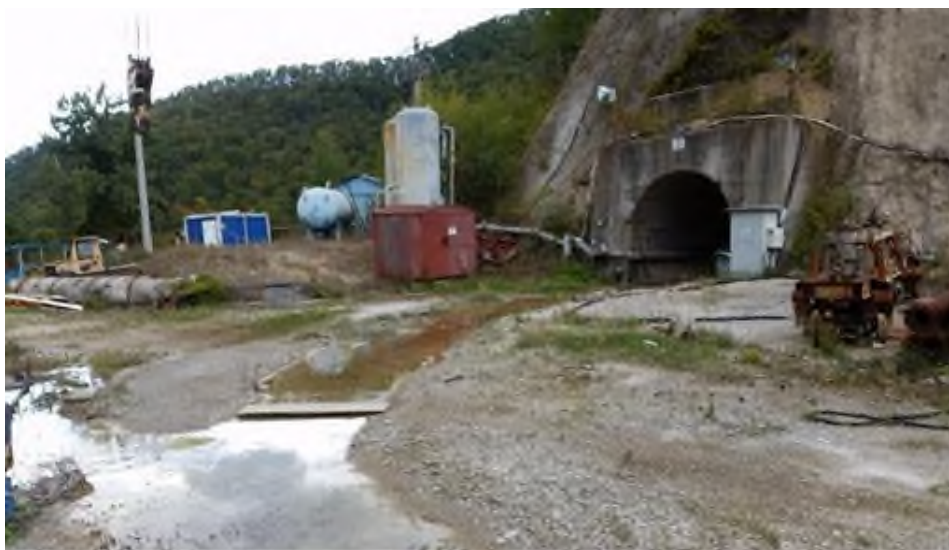
Fig. 47 Portalul galeriei de aducțiune de la front castel
