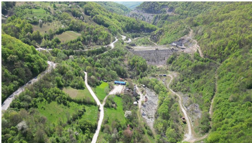
Fig. 73 – Imagine aeriană cu extremitatea aval a viitorului lac de acumulare Cornereva
