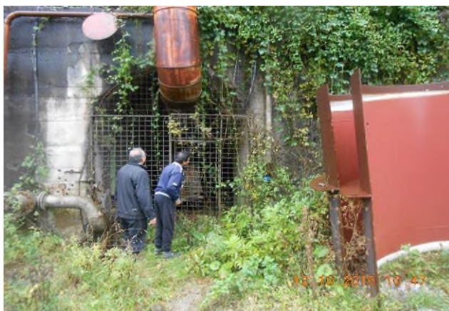
Fig. 45 Platforma tehnologică Bolvașnița II
