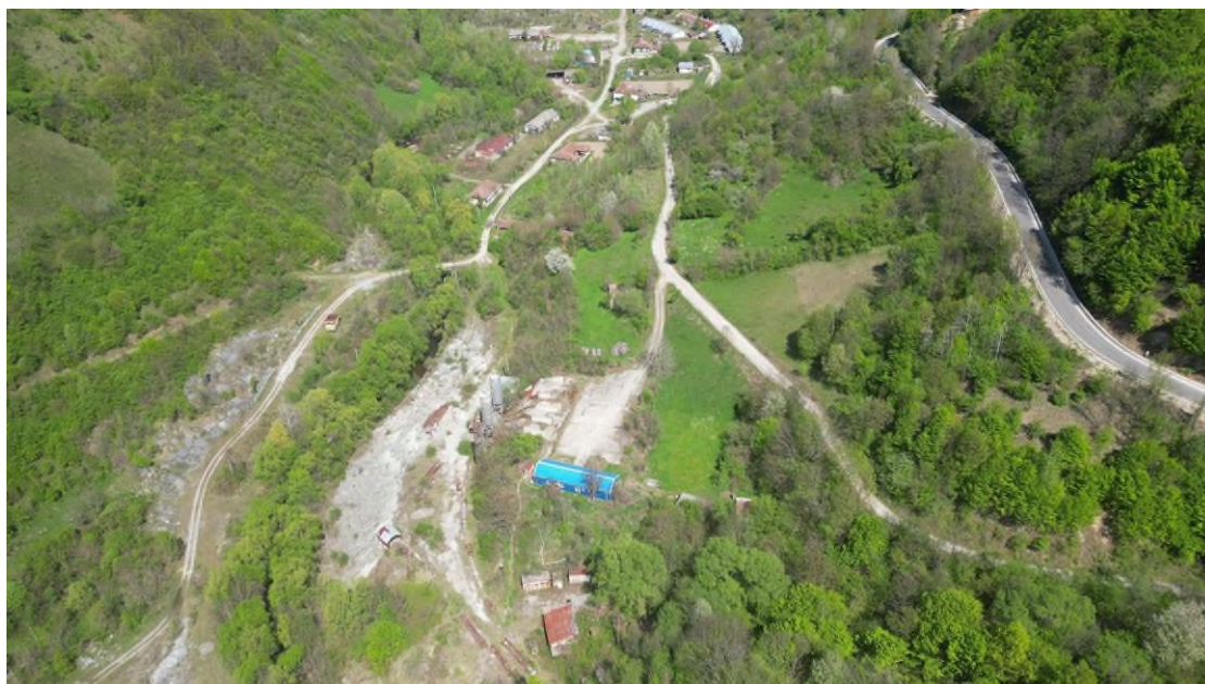
Fig. 75 – Imagine aeriană cu arealele puternic disturbate de lucrările de șantier din arealul aval al viitorului lac de acumulare Cornereva, în punctul unde începe galeria de aducțiune spre Cerna
