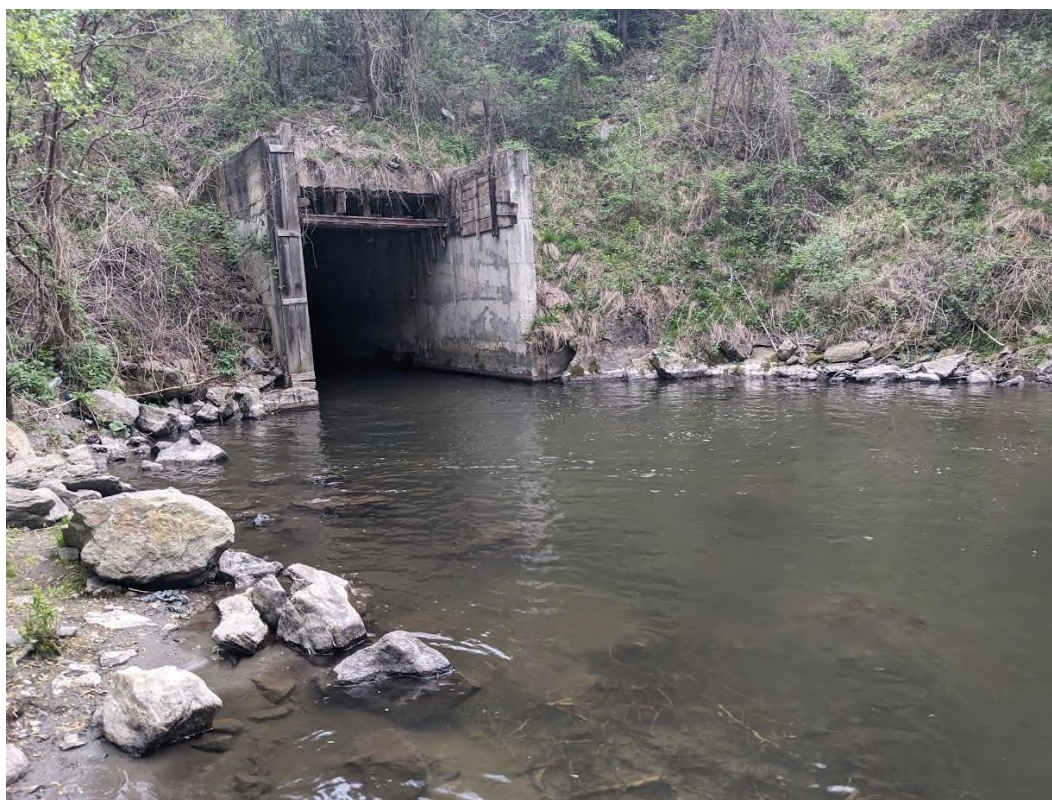
Fig. 204 Evacuarea apei râului Belareca aval baraj Cornereva
