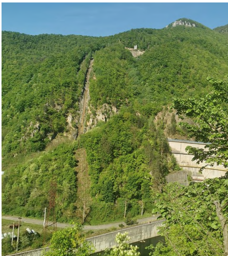
Fig. 116 – Extinderea castelului de echilibru, nodului de presiune și conductei forțate pe versantul drept al Cernei
