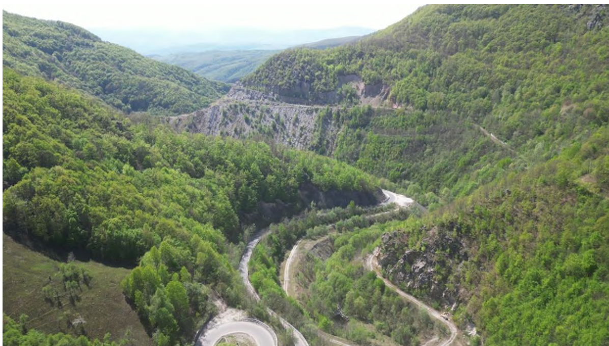
Fig. 66 – Imagine aeriană cu porțiunea aval a văii Belareca față de baraj, cu numeroase prelucrări ale versanților văii, din anii 80 ai secolului trecut
