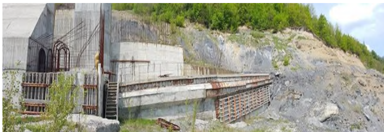
Fig. 35 Evacuatorul de ape mari. Vedere din aval
