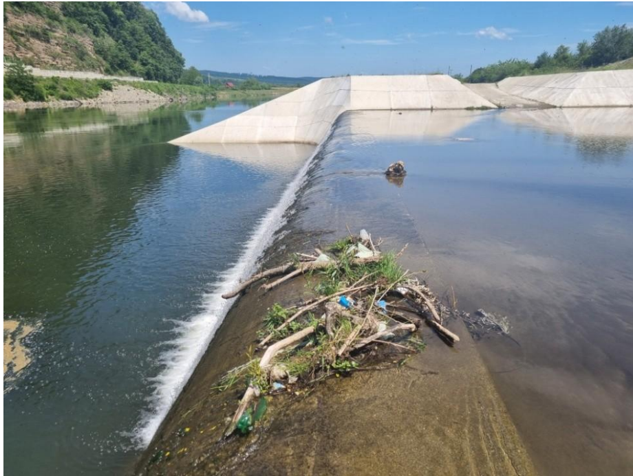
Foto nr. 63 Coronament deversor la debrușarea pr. Șebeș
