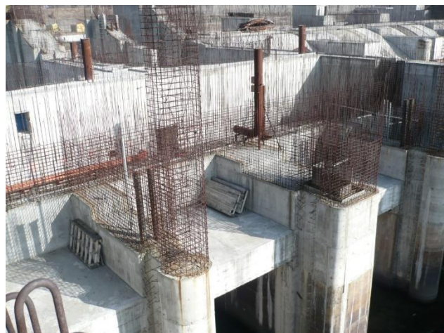
Foto 12. Centrala – zona pile aval
