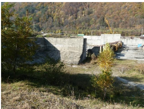
Foto 6. Două tronsoane de zid aval executate până la cota 339,50 mdMB
