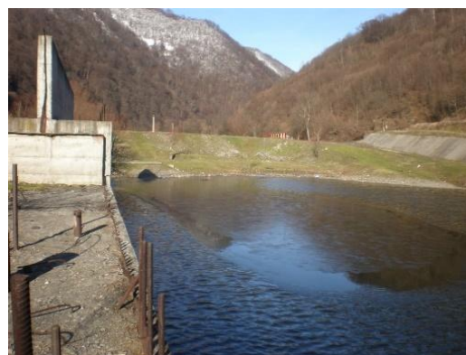
Foto 19. Incinta de execuție inundată
