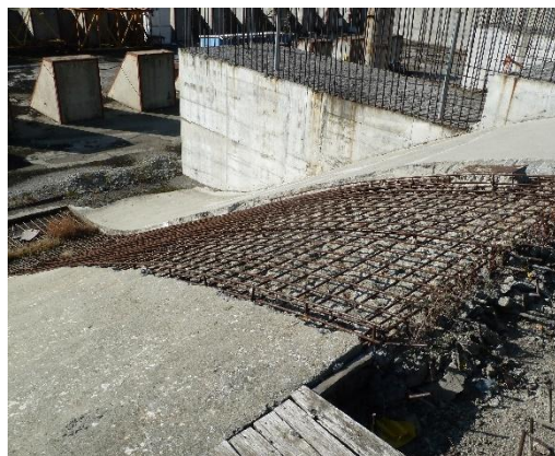
Foto 3. Vedere din amonte spre aval – deschiderea nr. 3 unde a rămas nebetonat profilul deversant pe o fâșie de 4 m lățime
