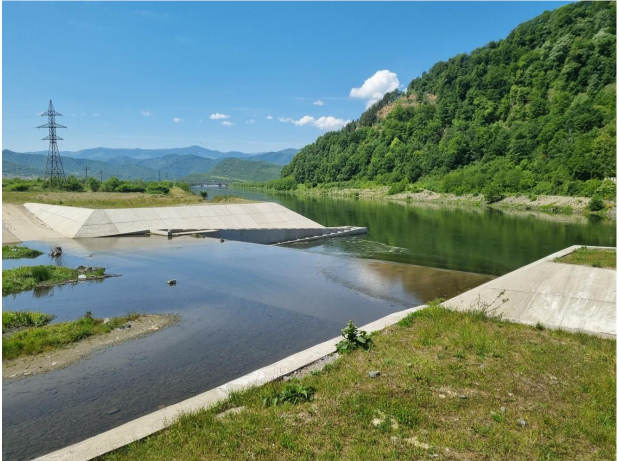
Foto nr. 61 Amenajarea debrușării râului Șebeș
