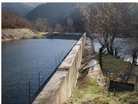
Foto 18. Pila despărțitoare poziționată pe mijlocul barajului deversor
