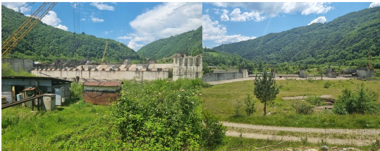
Foto nr. 68 Construcții existente CHE Căineni
