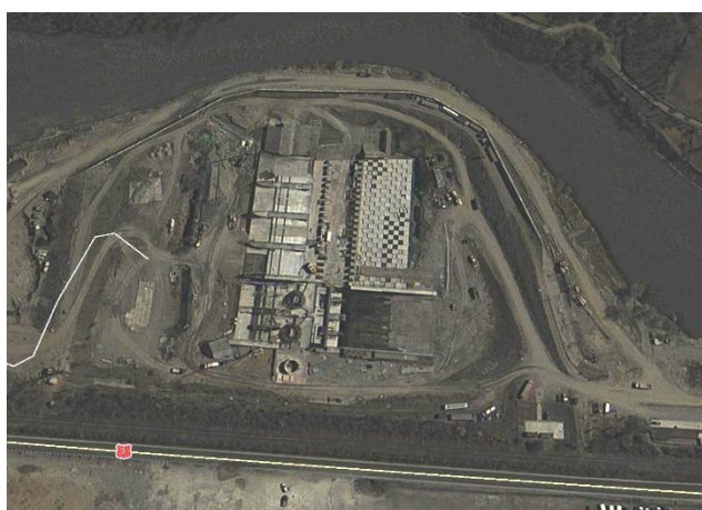
Foto 21. Incinta de execuție și stadiul lucrărilor la nodul Căineni
