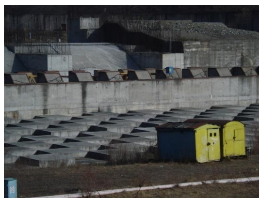
Foto 5. Rizberma fixă executată la cotă finală
