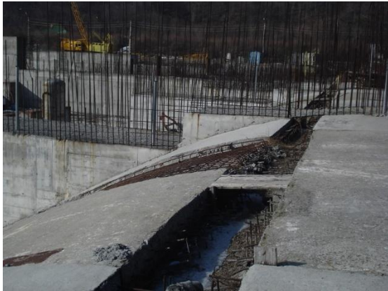
Foto 22. Vedere din amonte spre aval – deschiderea nr. 3 unde a rămas nebetonat profilul deversant pe o fâșie de 4 m lățime
