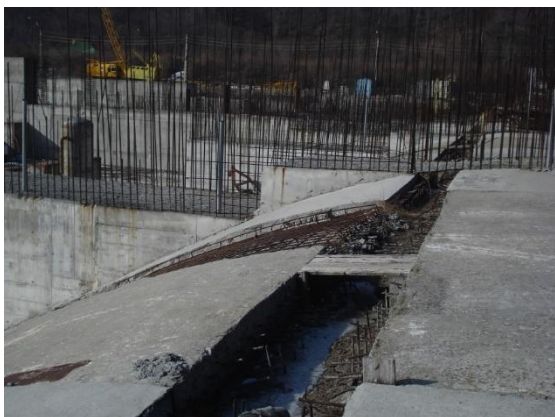
Foto 3. Vedere din amonte spre aval – deschiderea nr. 3 unde a rămas nebetonat profilul deversant pe o fâșie de 4 m lățime
