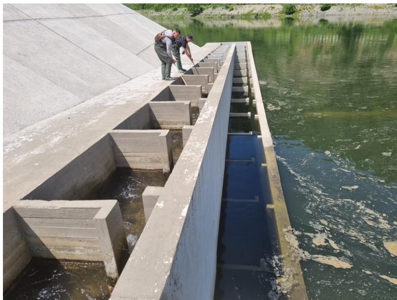
Foto nr. 64 Scară de pești existentă
