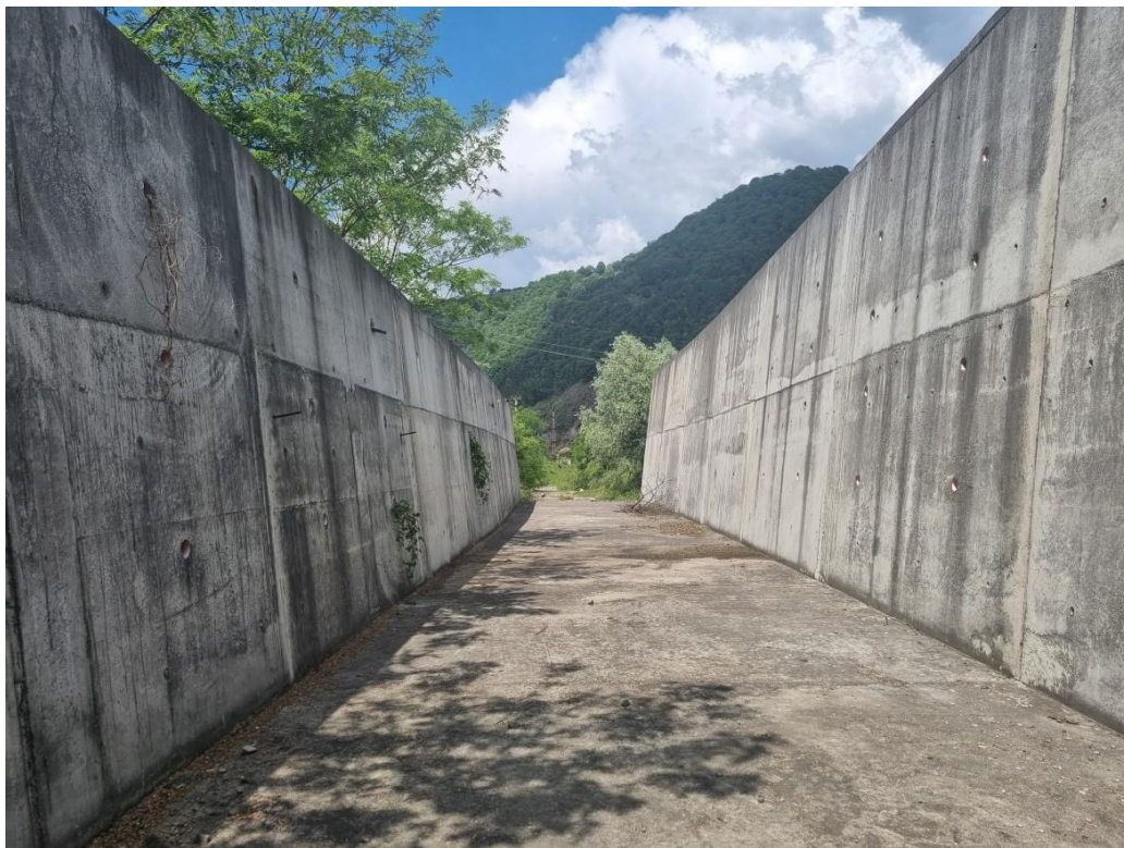
Foto nr. 69 Tronson existent cuvă beton
