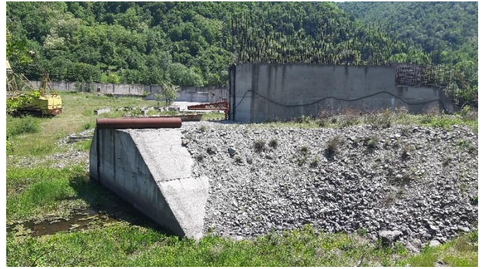
Foto 8. Zid amonte mal drept primul tronson executat
