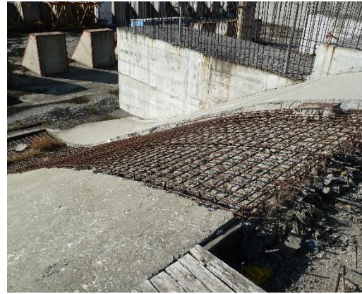
Foto 22. Vedere din amonte spre aval – deschiderea nr. 3 unde a rămas nebetonat profilul deversant pe o fâșie de 4 m lățime
