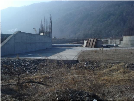
Foto 7. Zid amonte mal stâng și regularizare amonte
