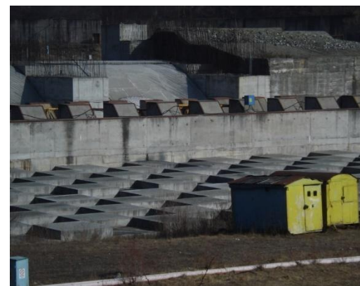
Foto 24. Rizberma fixă executată la cotă finală
