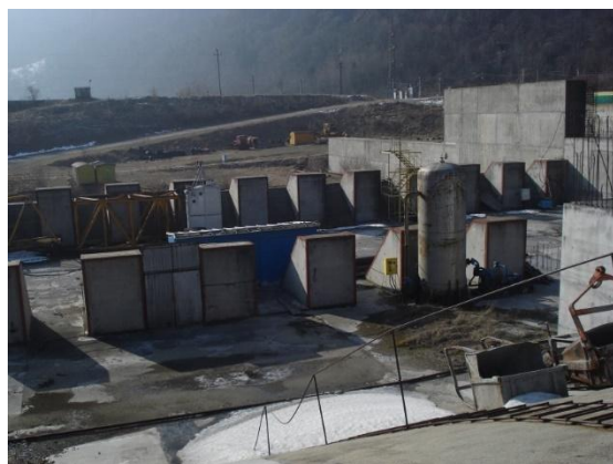
Foto 23. Disipatorul de energie – vedere de pe creasta descărcătorului
