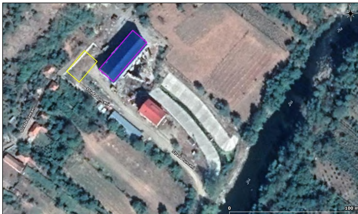
Fig. 13 – Încadrarea în teritoriu a clădirii CHE Bumbești (poligon de culoare mov) și a stației de transformare 110 kV CHE Bumbești (poligon de culoare galbenă)
