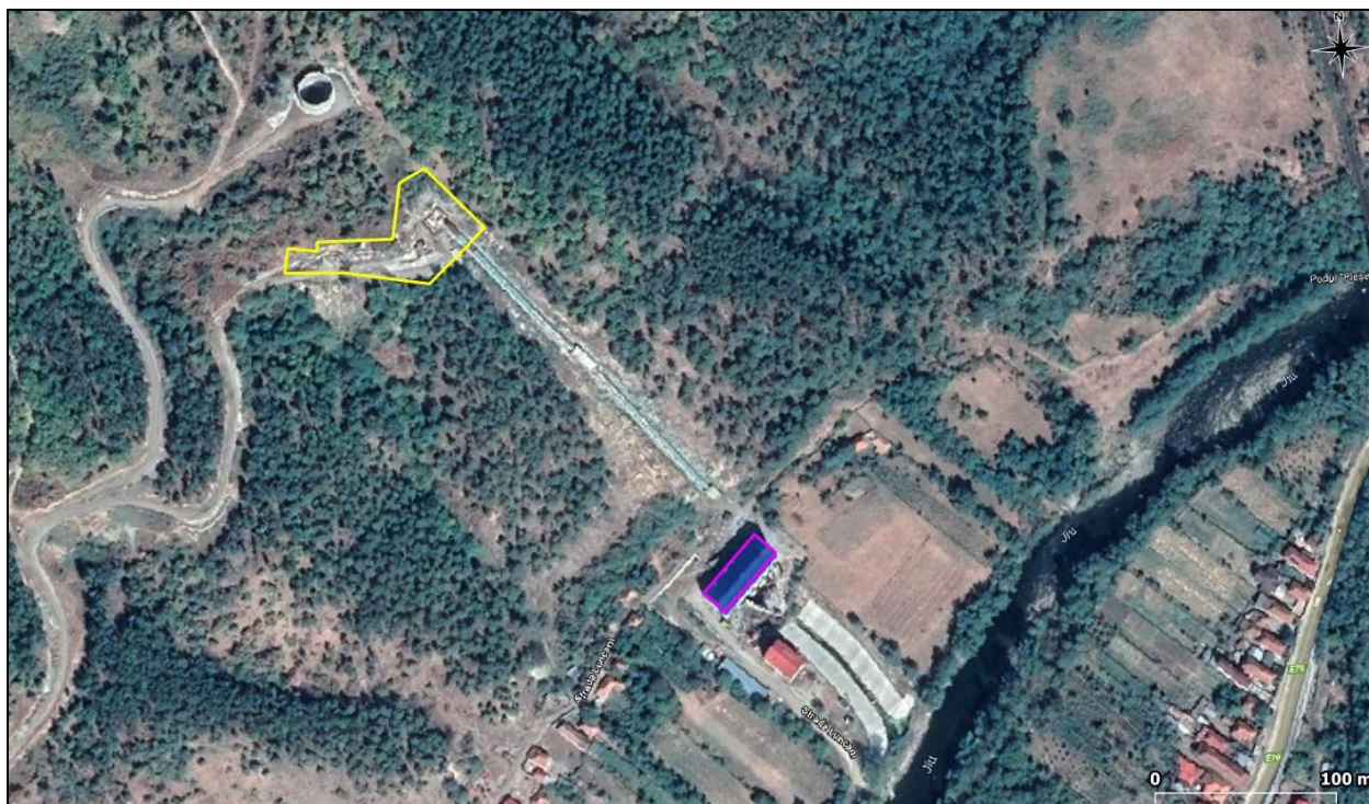
Fig. 9 – Încadrarea în teritoriu a clădirii CHE Bumbesti (poligon de culoare mov) și a casei de vane (poligon de culoare galbenă)
