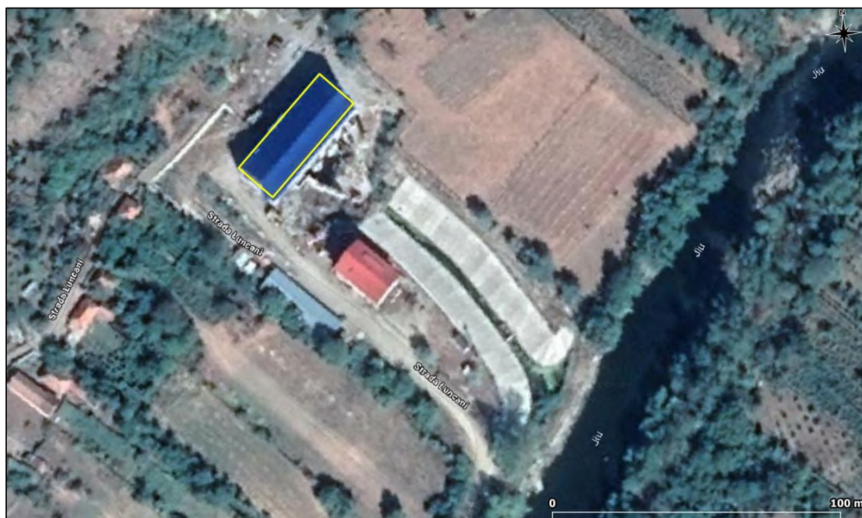
Fig. 10 – Încadrarea în teritoriu a clădirii CHE Bumbesti (perimetru de culoare galbenă)
