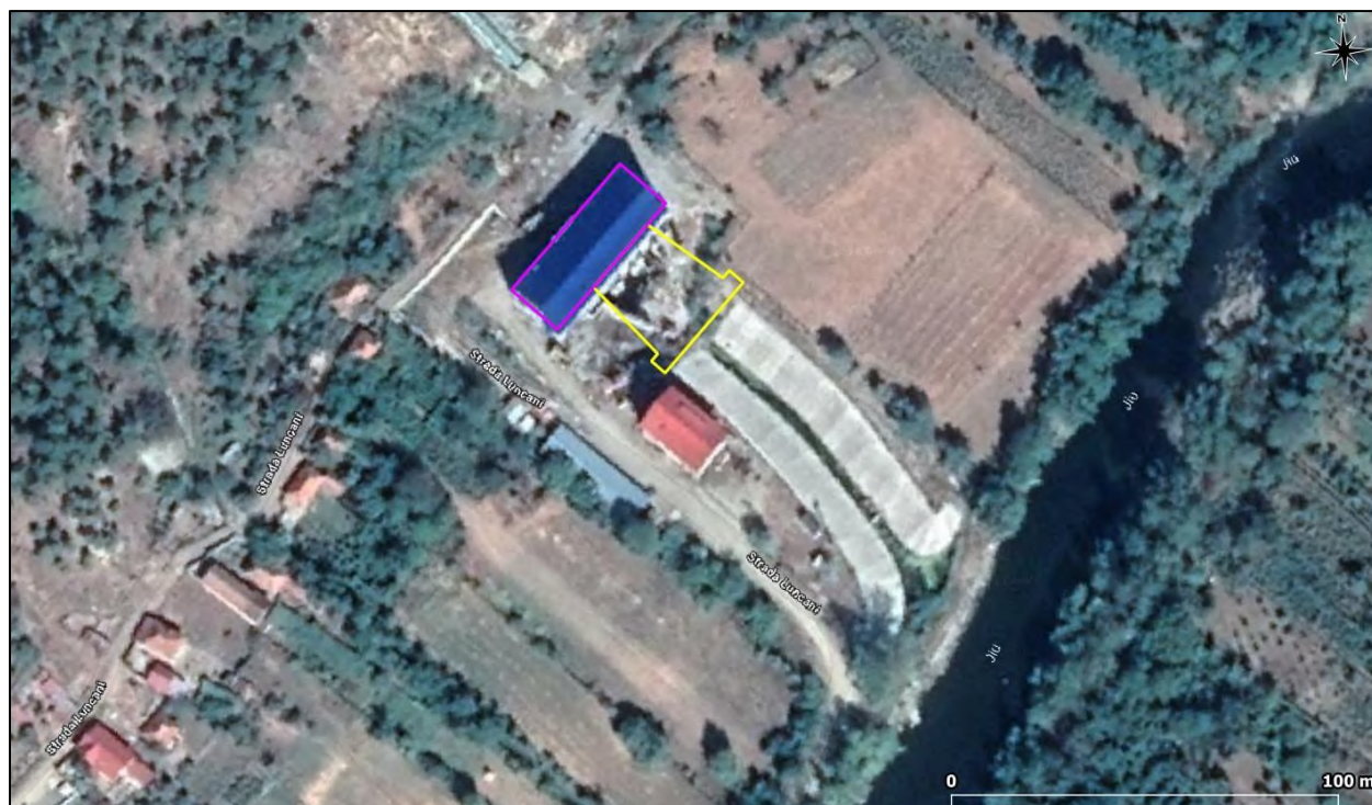
Fig. 12 – Încadrarea în teritoriu a clădirii CHE Bumbesti (poligon de culoare mov) și a zonei de racord dintre bazinul de liniștire al CHE Bumbesti și canalul de fugă (poligon de culoare galbenă)
