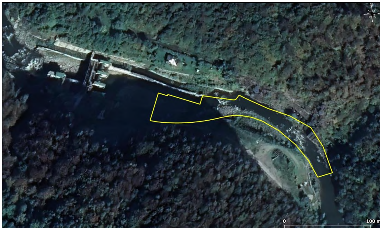
Fig. 4 – Localizarea sectorului albiei Jiu vizat de lucrări de regularizare în aval de barajul Livezeni
