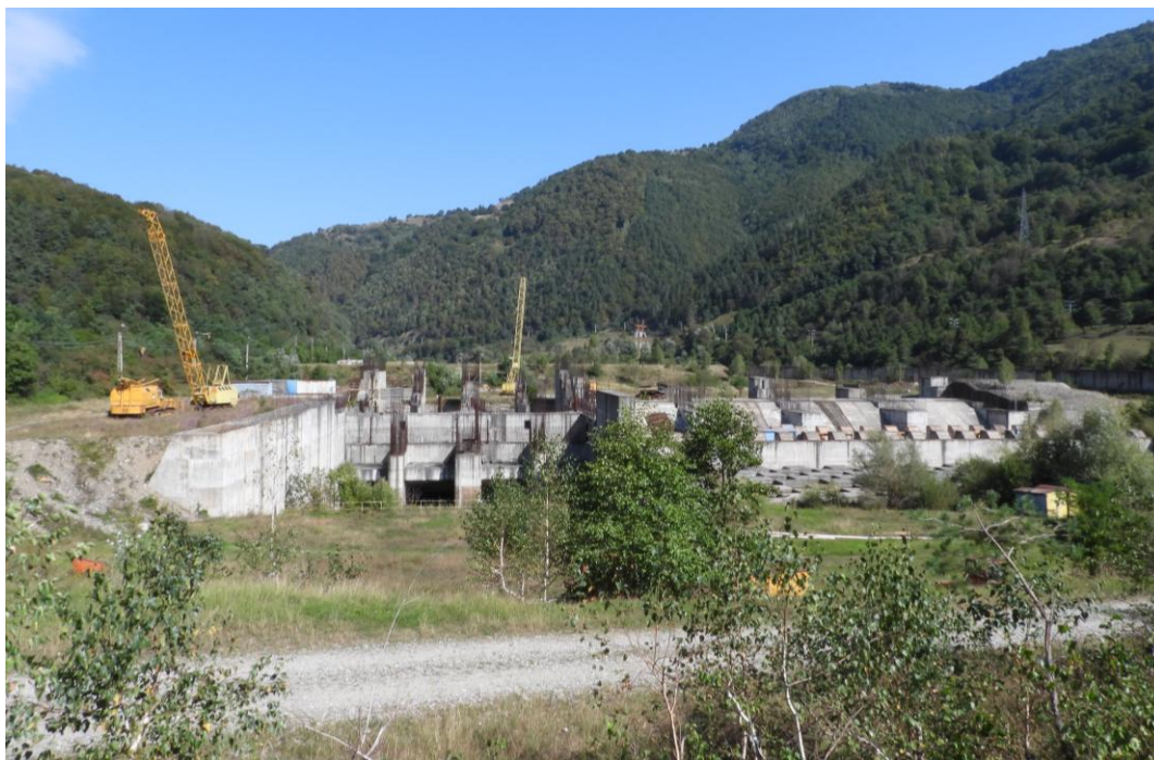
Figura 11. Centrala CHE Căineni, zona prizei și camera spirală – vedere din aval
