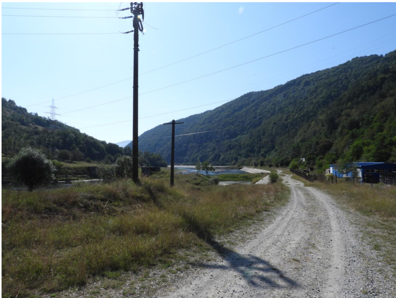
Figura 8. Vedere aval CHE, Căineni
