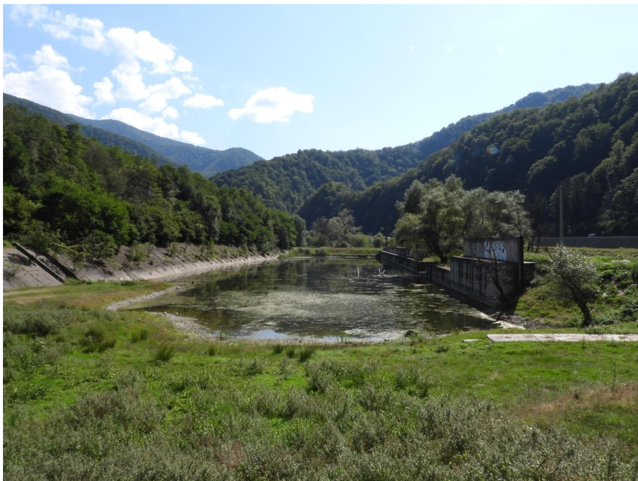
Figura 14. Centrala CHE Lotrioara
