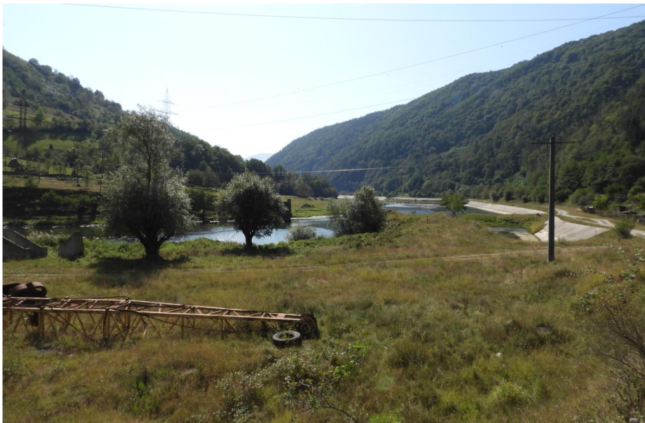
Figura 13. Vedere aval - zona Canal de Fugă CHE Căineni
