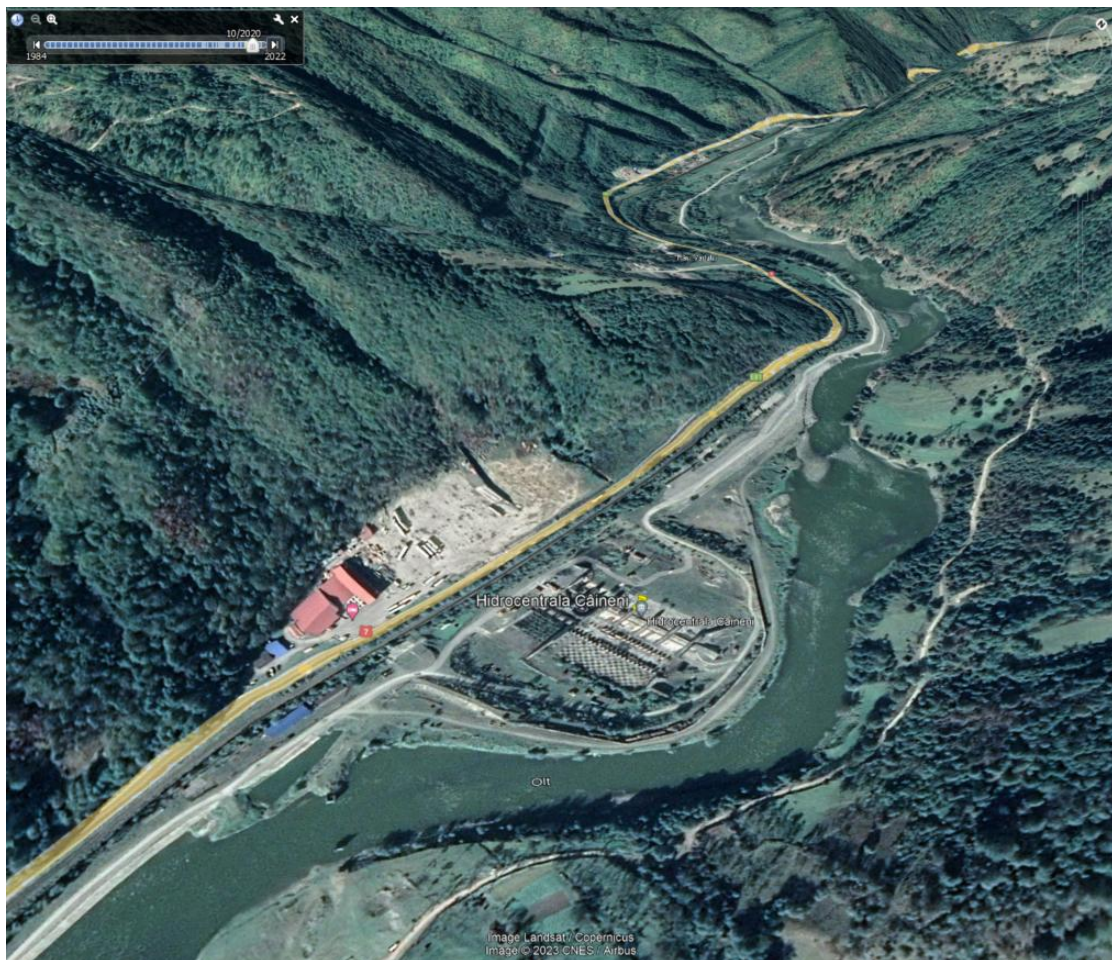
Figura 9. CHE Căineni – vedere de ansamblu; Sursă Google Earth
