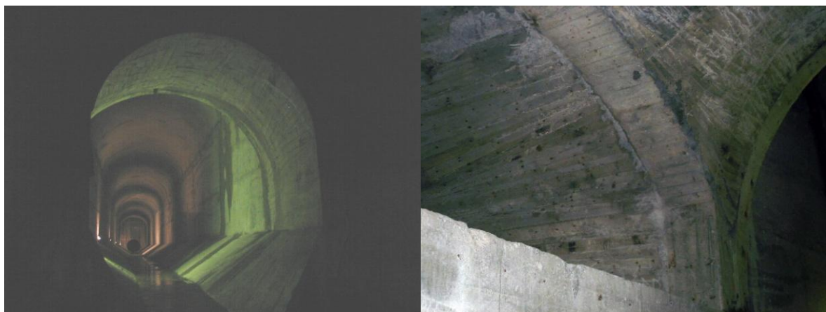
Foto 9 Imagini din interiorul decantorului betonat
