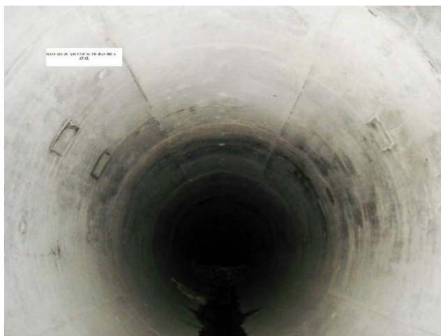
Foto 8 Aducțiune betonată Murga aval
