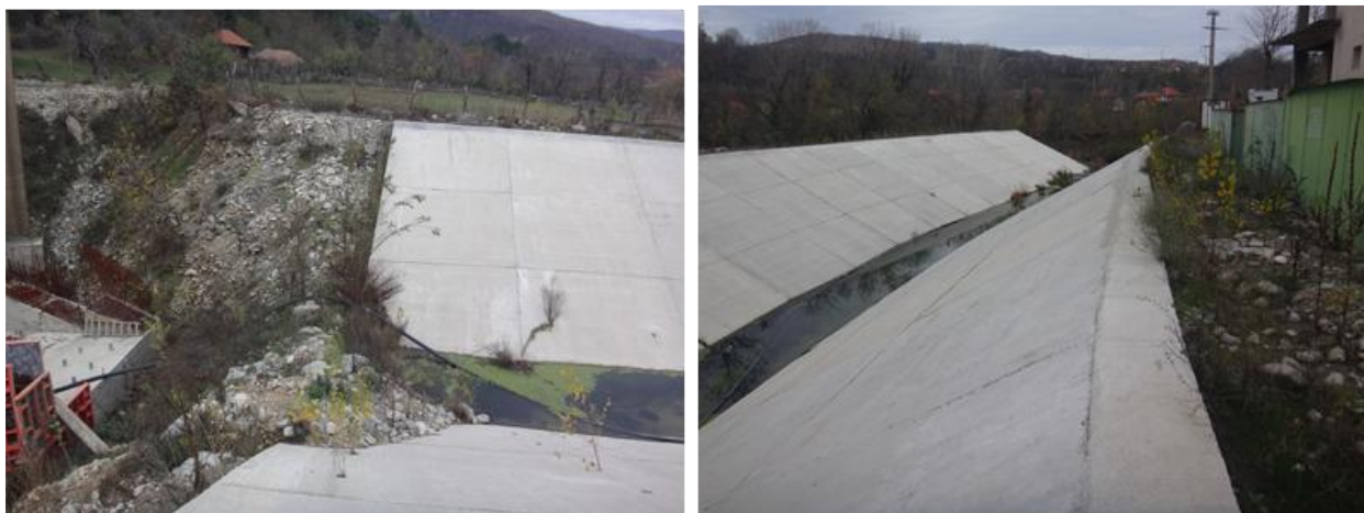
Foto 12 Canalul de fugă la racordul cu bazinul de liniștire și vedere în lung
