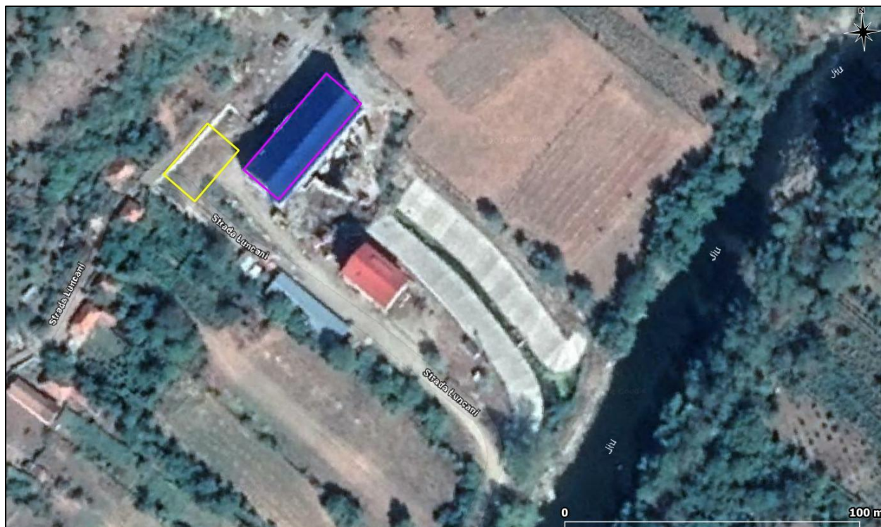
Figura nr. 23 Încadrarea în teritoriu a clădirii CHE Bumbști (poligon de culoare mov) și a stației de transformare 110 kV CHE Bumbști (poligon de culoare galbenă)
