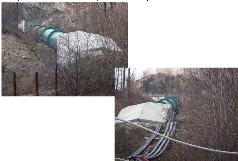
Foto 5 Conducta forțată de la nodul de presiune al CHE Dumitra
