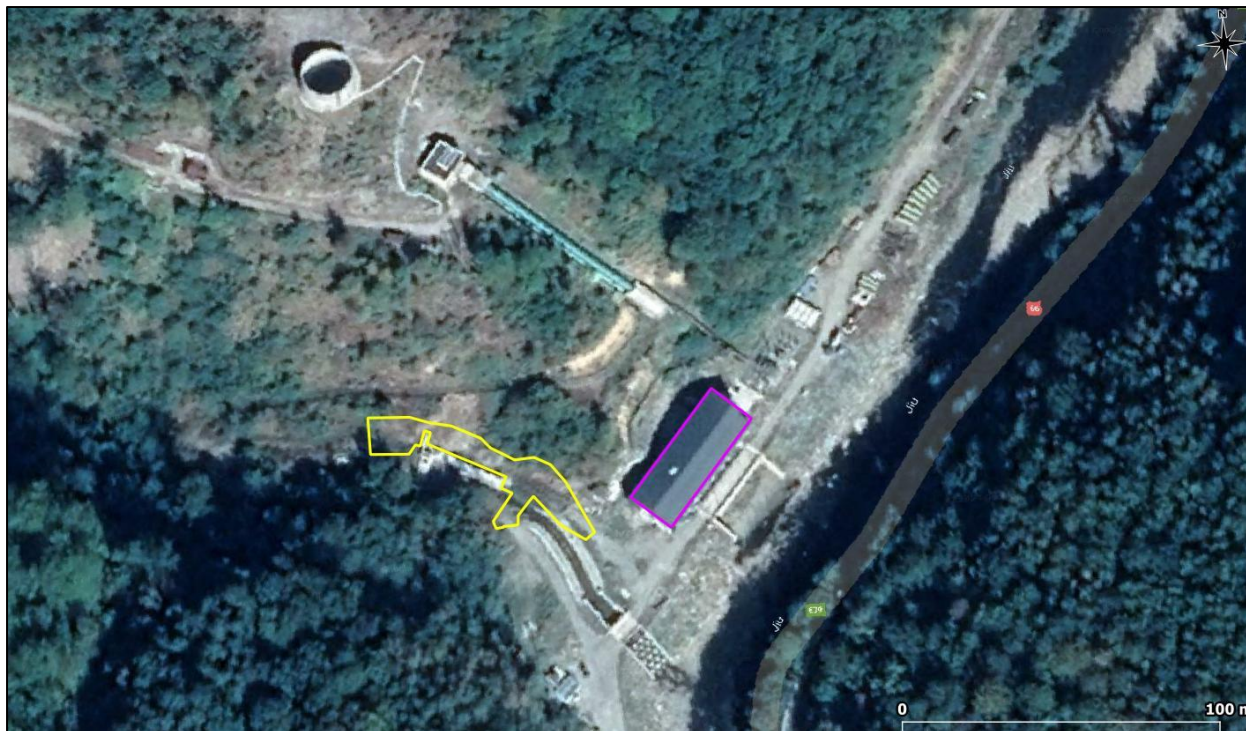
Figura nr. 17 Încadrarea în teritoriul a clădirii CHE Dumitra (poligon de culoare mov) a captării Dumitra și a drumului de acces peste pragul de captare Dumitra (poligon de culoare galbenă)
