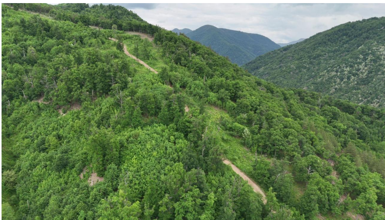
Foto 48 Habitatul 91L0 în regenerare pe pantele mai puțin înclinate de deasupra castelului de echilibru al CHE Bumbesti
