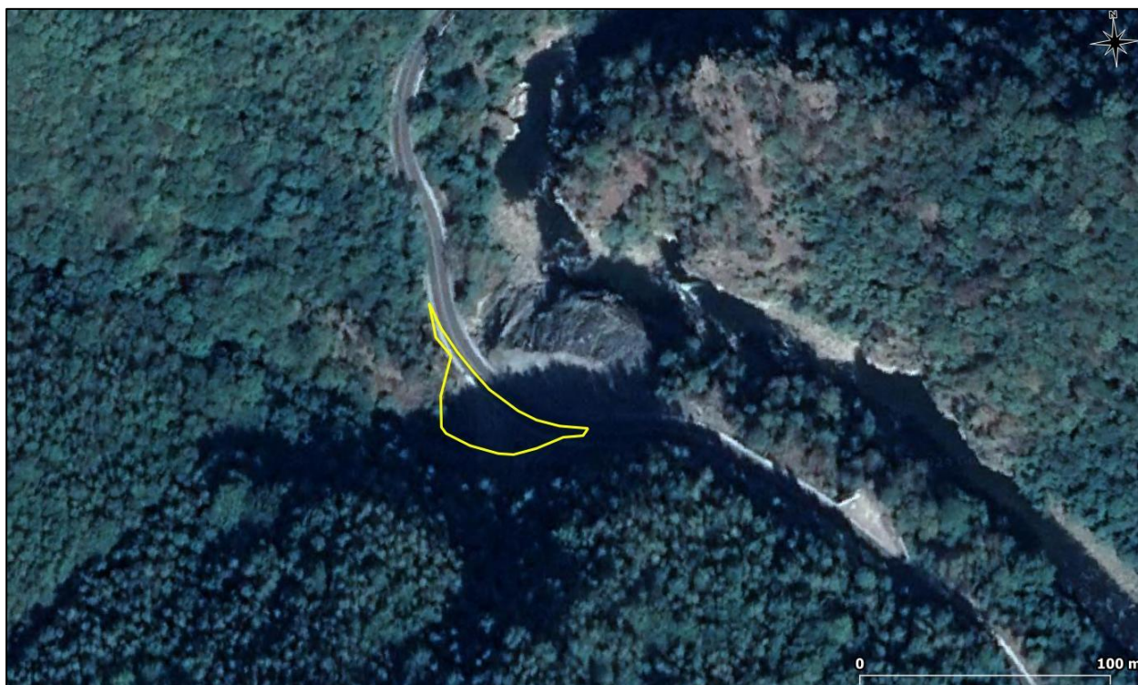
Figura nr. 31 Încadrarea în teritoriu a platformei tehnologice de la Fereastra de atac Murga Mică (poligon de culoare galbenă), obiectiv vizat de lucrări de amenajare
