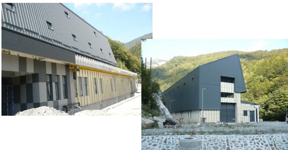
Foto 6 CHE Dumitra - exterior
