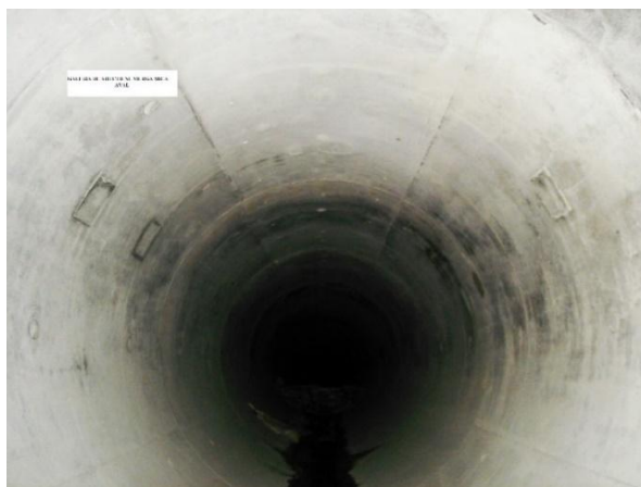
Foto 3 Aducciune betonată Murga aval
