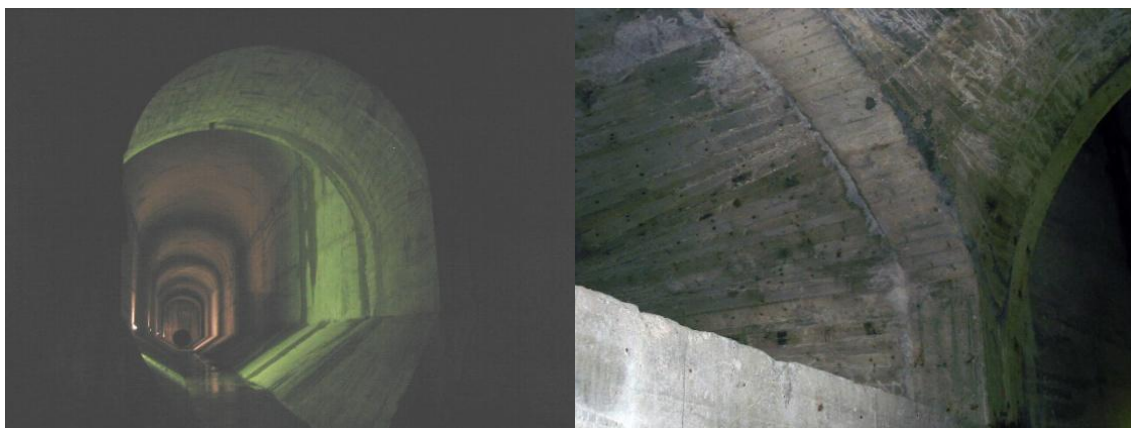
Foto 4 Imagini din interiorul decantorului betonat
