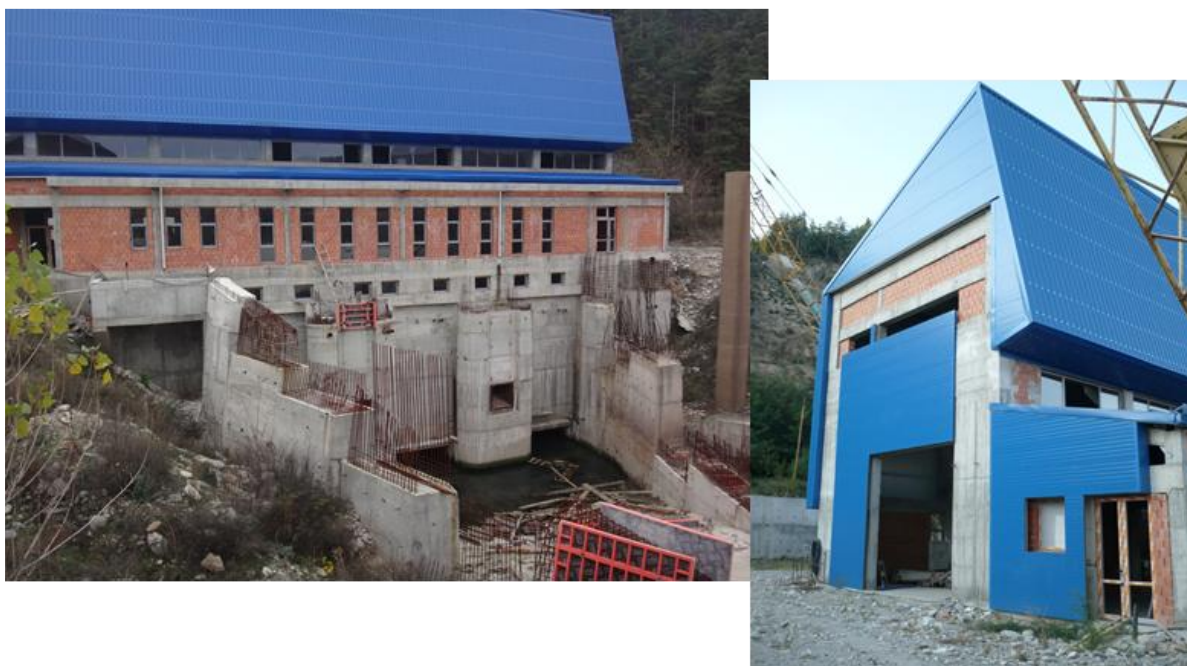
Foto 16 CHE Bumbesti - exterior
