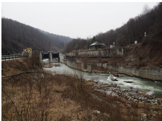
Vedere baraj din aval
