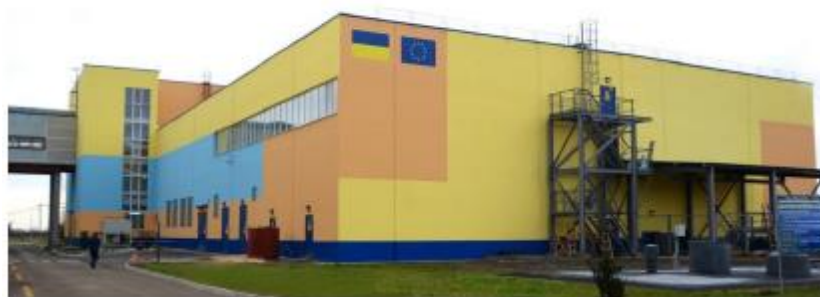
Figura 2.9. Exteriorul clădirii CRWP
