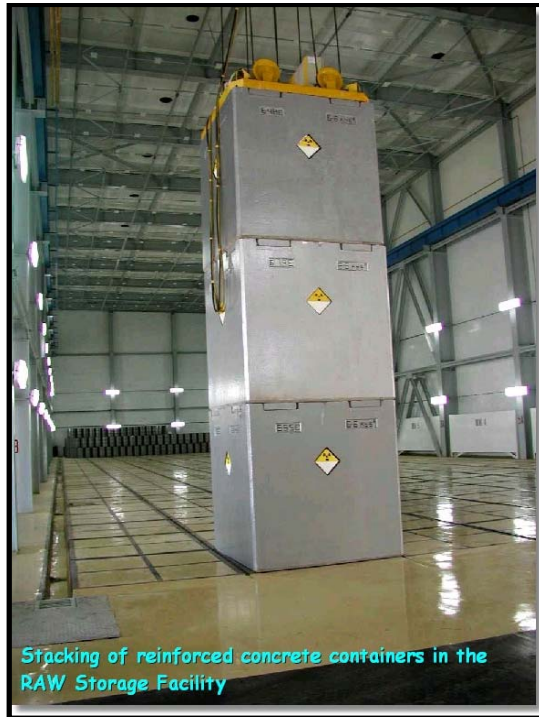
FIGURĂ 0-4 CONTAINERE DIN OȚEL BETON PENTRU ÎNGROPAREA DRA ÎN DNDRA
